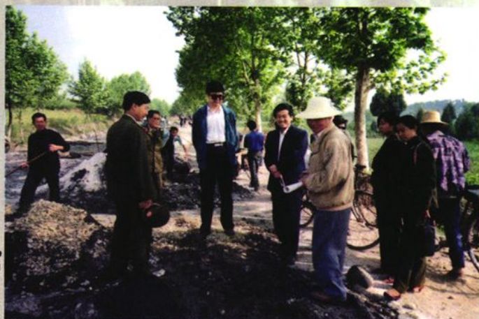
原游仙区委书记左代富 检查魏刘路施工情况
