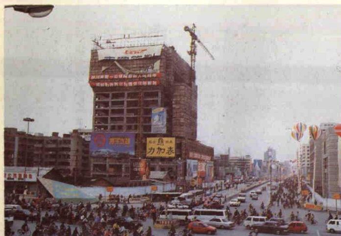
正在建设中的四川金属大楼
