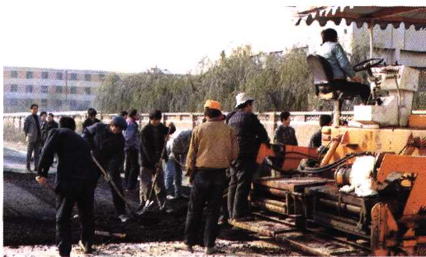
市政所道路工程队 施工现场
