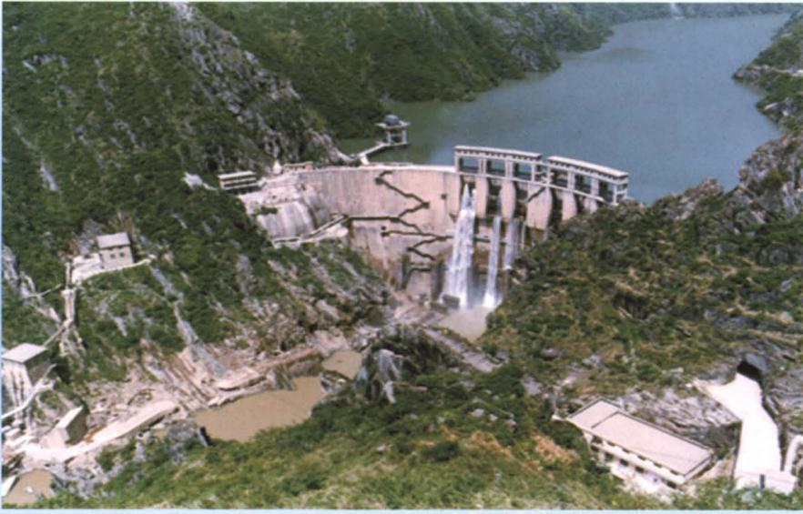
石门水库。其大坝为混凝土双曲拱坝，最大坝高88米，总库容1.05亿米<sup>3</sup>，获水利电力部优质工程奖
