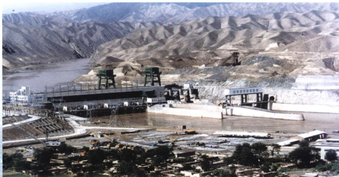
大峡水电站。其大坝为河床式混凝土重力坝，装机总容量30万千瓦
