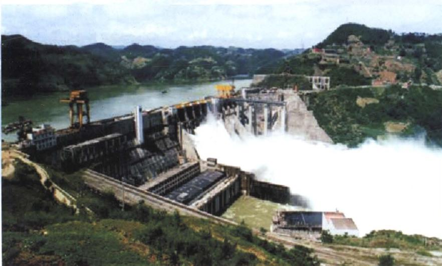
安康水电站。其大坝为折线式混凝土重力坝，坝高128米，总库容25.85亿米<sup>3</sup>，总装机80万千瓦，安康水电站主体混凝土获能源部优质工程奖
