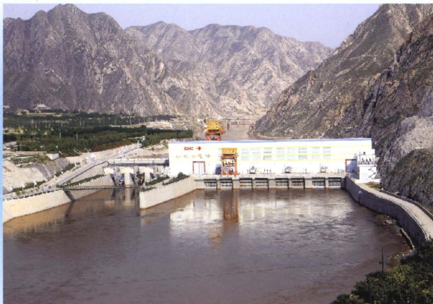
小峡水电站。其大坝为混凝土重力坝，总装机容量为23万千瓦。获中国电力优质工程奖
