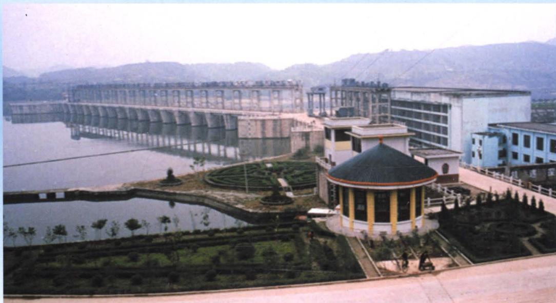
射洪螺丝池电航工程。该工程设有泄洪闸18孔，总长267米，总装机容量3.15万千瓦
