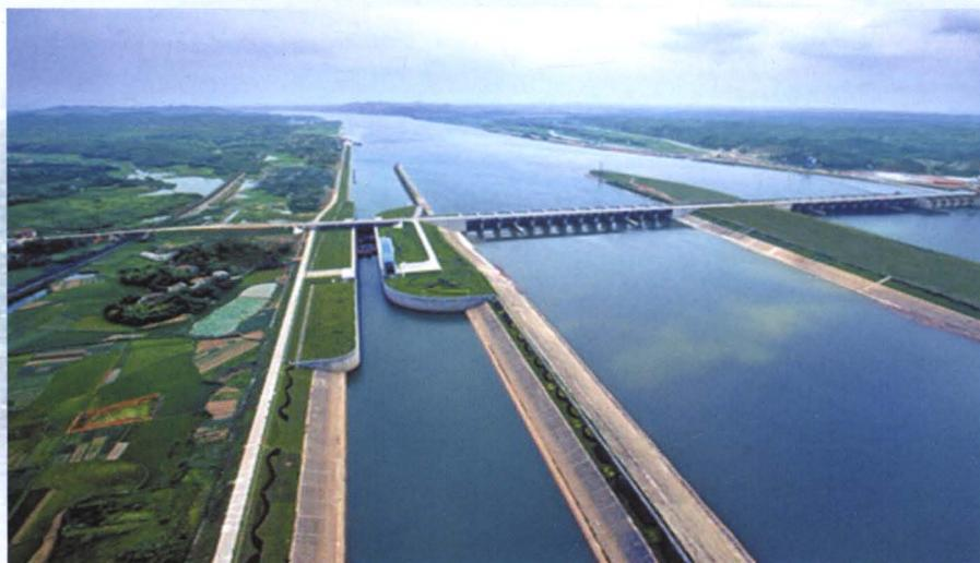
株洲航电枢纽。其建筑物主要有泄洪闸、船闸、电站厂房、坝顶公路，总装机容量14万千瓦
