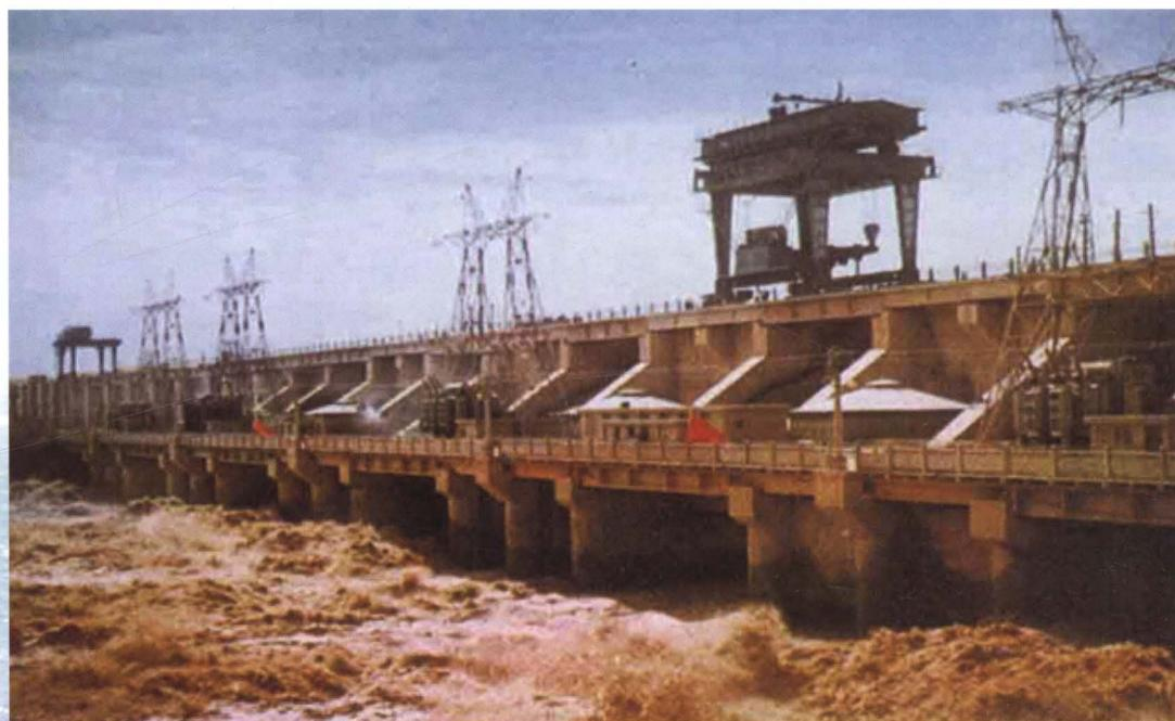
青铜峡水电站。其总装机容量27.2万千瓦，1958年8月开工建设，1968年第1台机组发电，1978年8月8台机组全部投产发电(该电站为我国第一座闸墩式水电站)
