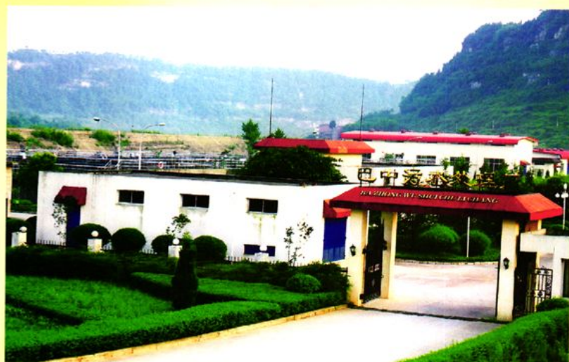
日处理污水4万吨的巴中污水处理 厂位于南坝下游
