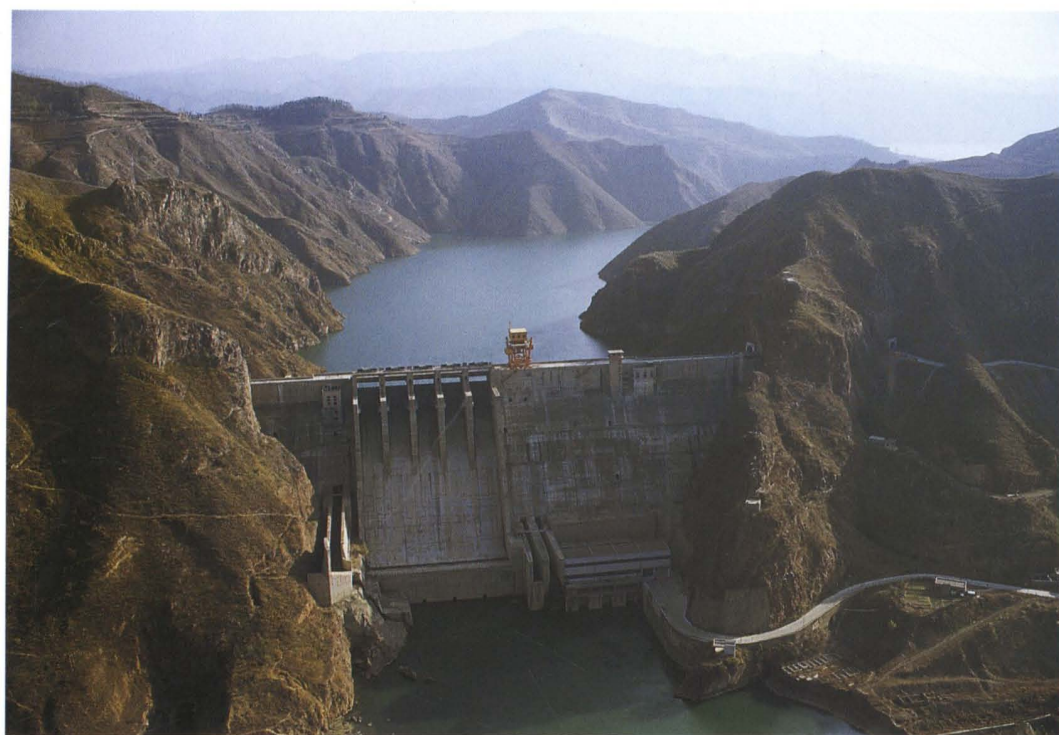
洛河故县水库大坝
