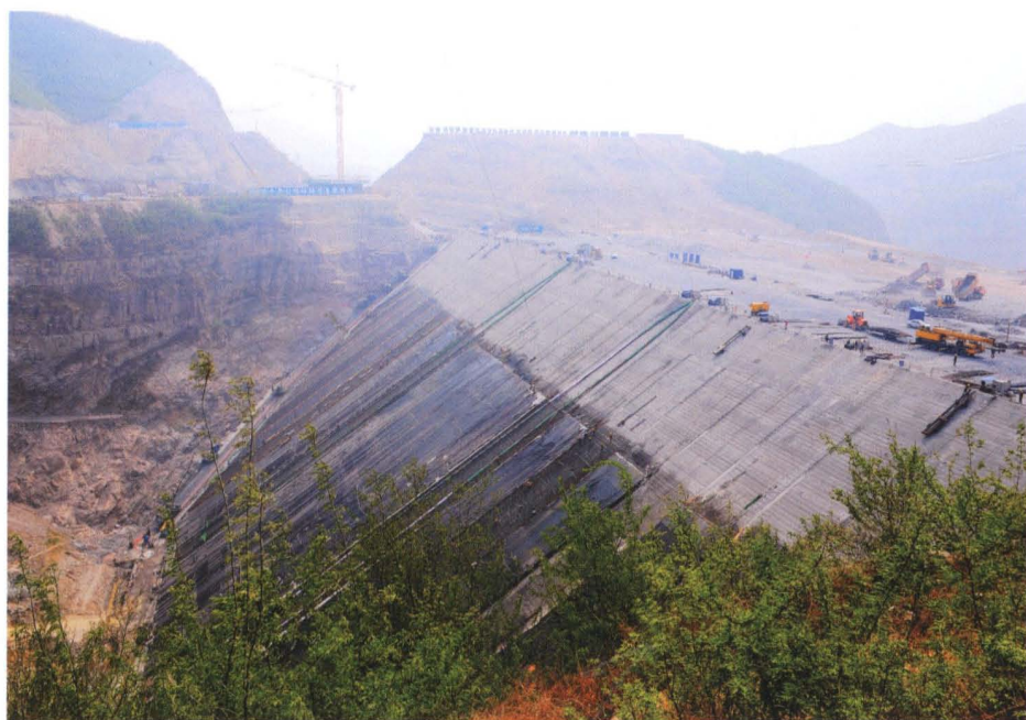
在建的沁河河口村水库大坝 于澜 摄
