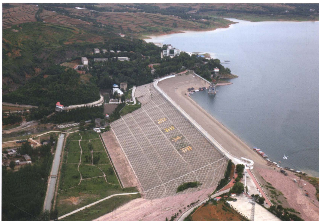
伊河陆浑水库大坝
