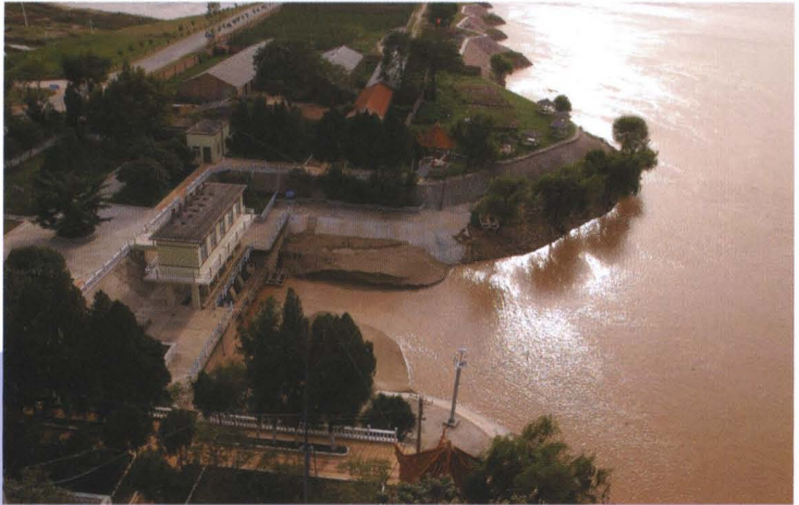
开封黑岗口闸 王舒 摄
