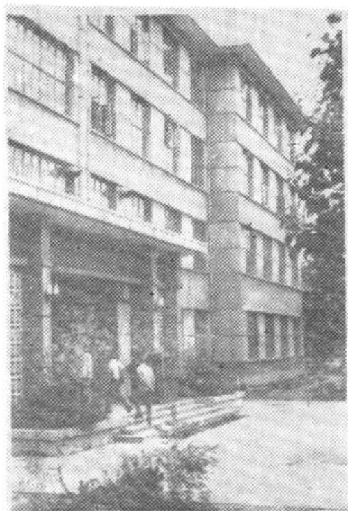
1982 年 学 院 (博山) 新建图书 馆楼 (上)、实验 楼 (下)
