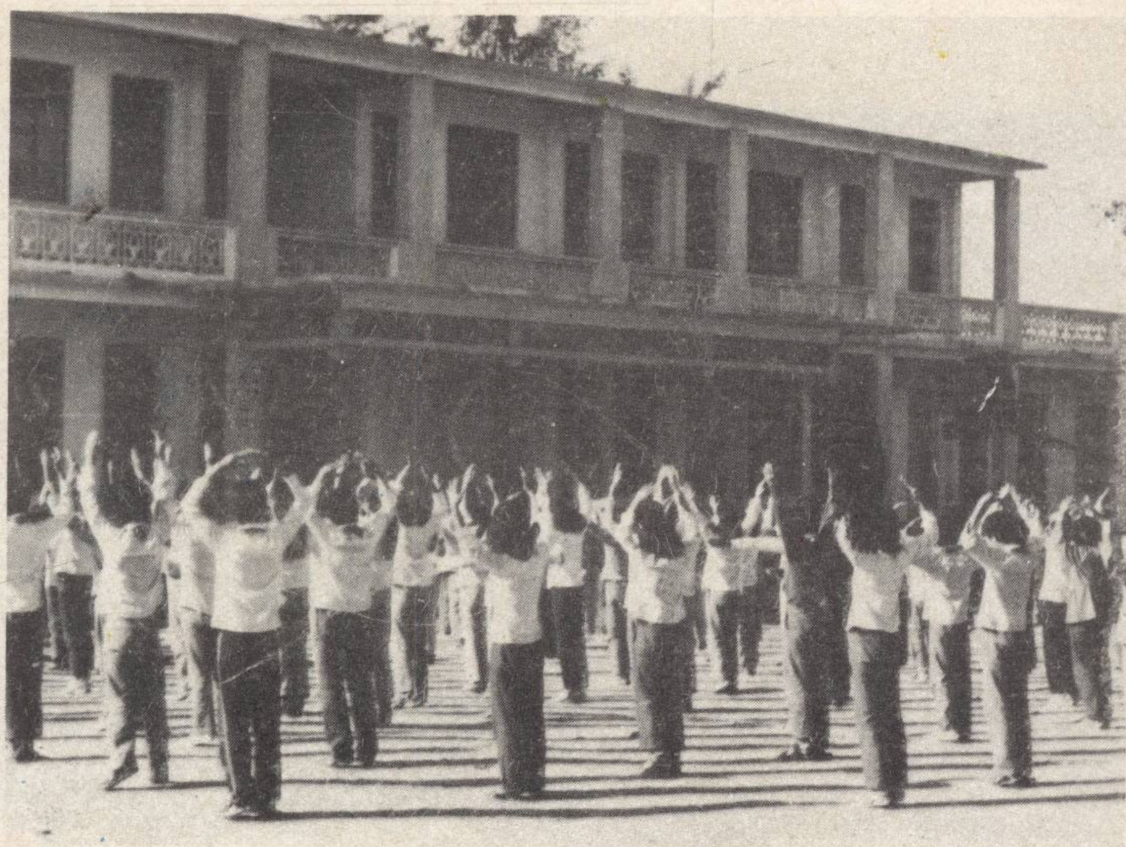
贯彻“三个一点”，集资五万元兴建的岭肚小学楼
