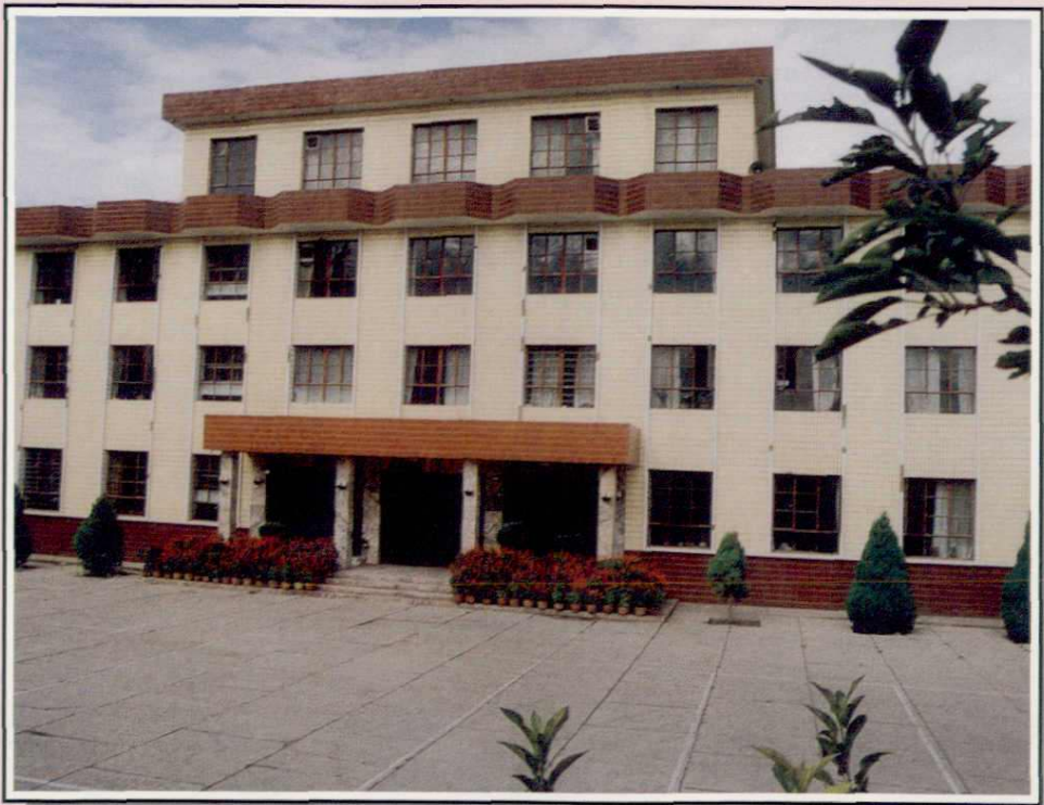
张掖地区行署粮食处办公楼
