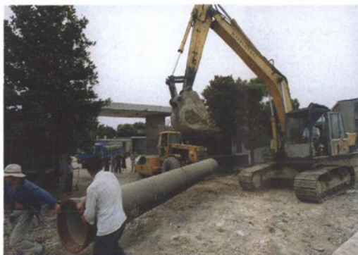
水厂接管通水现场
