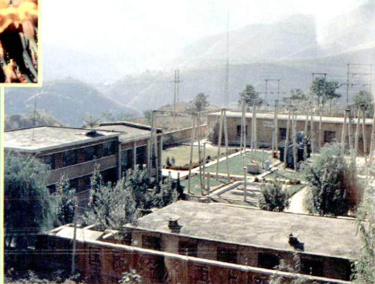
潮头 110 千伏变电站全景
