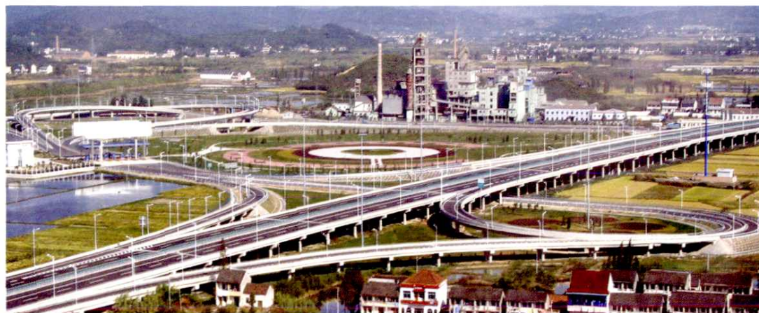
杭宁(杭州—南京)高速公路德清段
