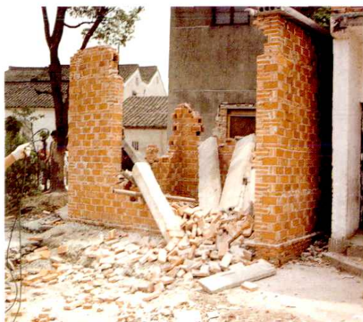
拆除违章建筑
