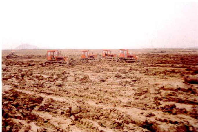
机械化施工的土地整理工作
