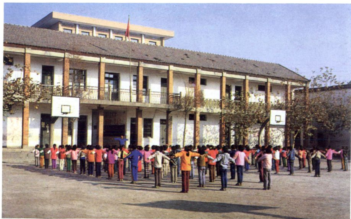
二层教学楼(1975 年建, 1998 年拆除)
