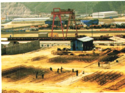
黔东火电厂施工现场
