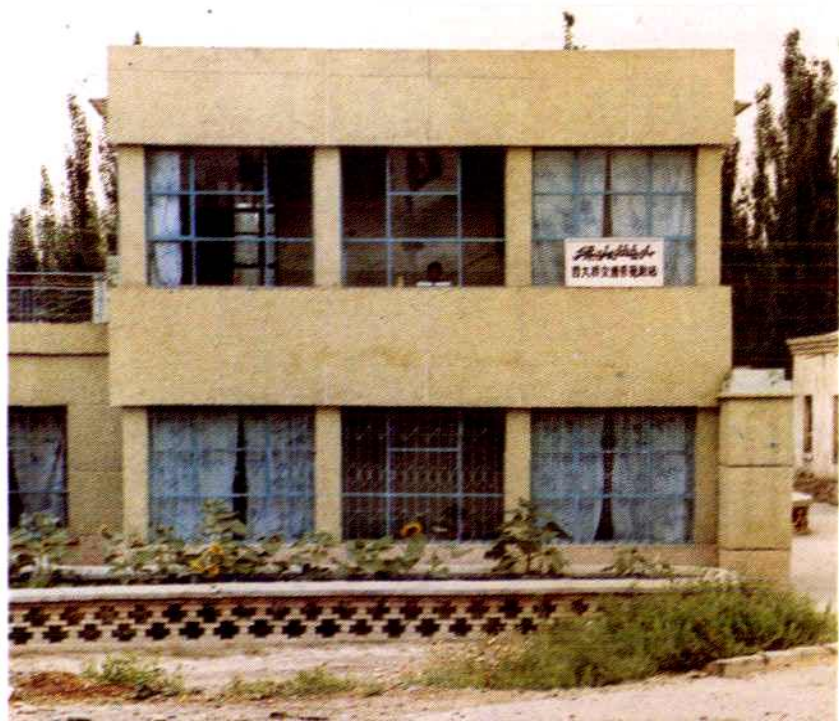
西大桥交通量 观测站
