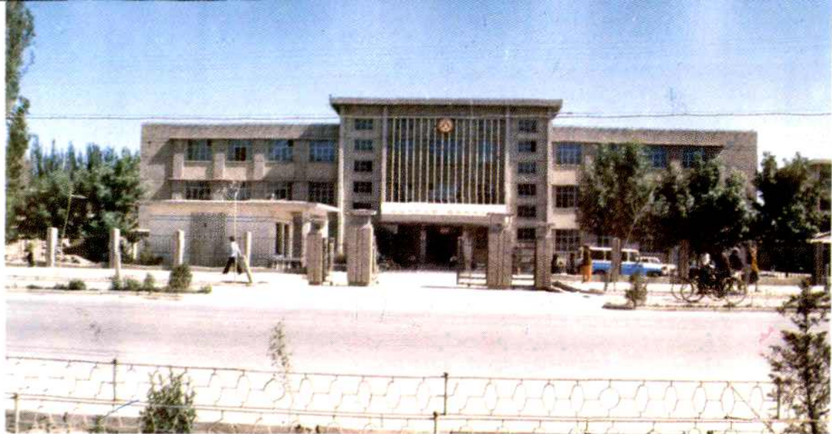
阿克苏公路总段办公楼
