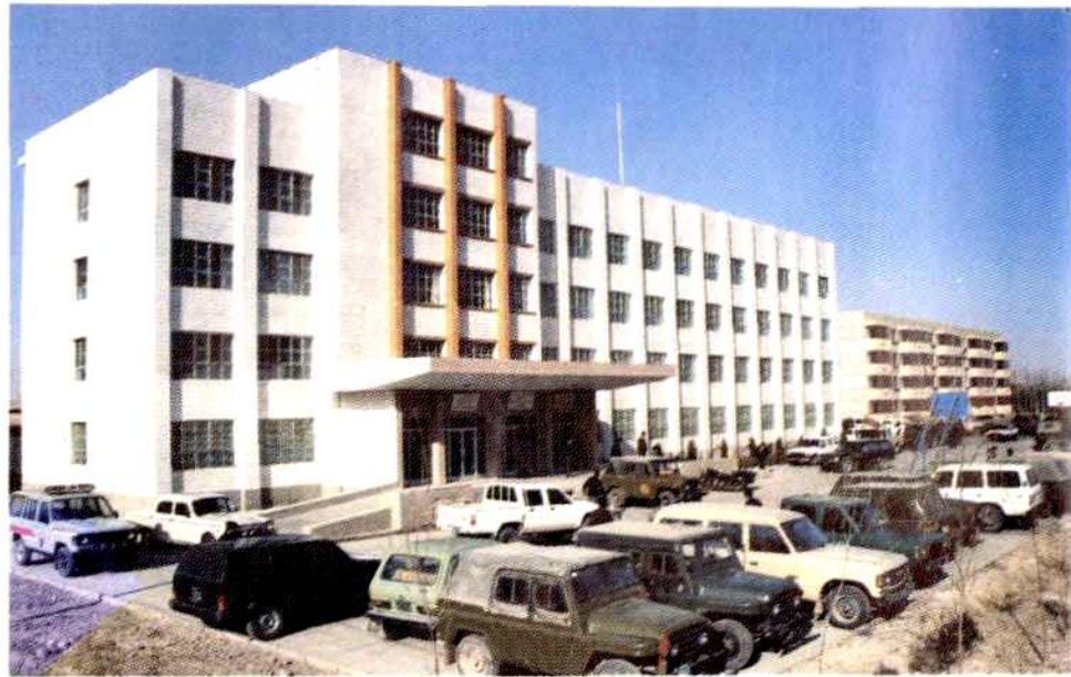
阿克苏地区交通处 办公楼
