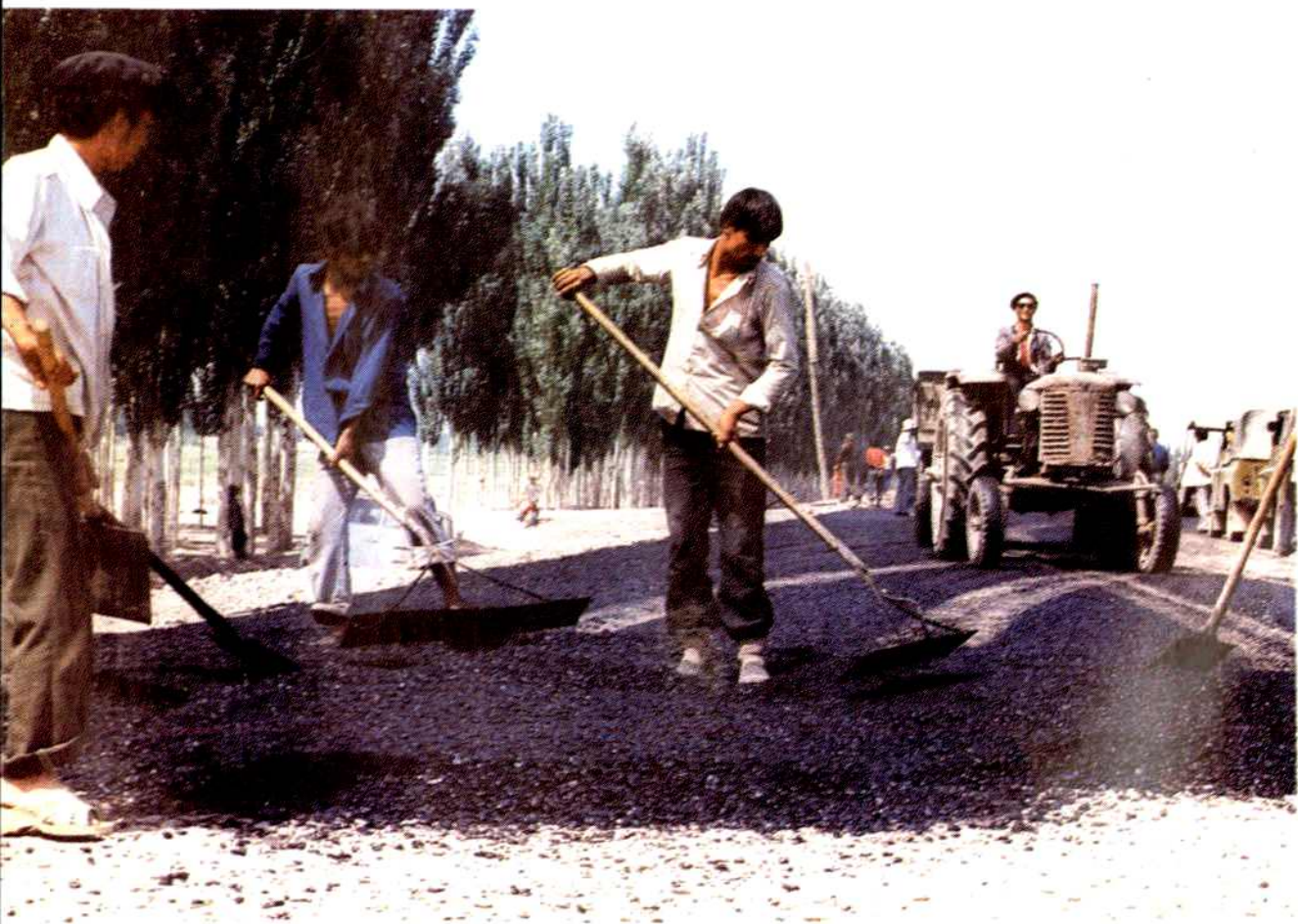
铺筑沥青路面
