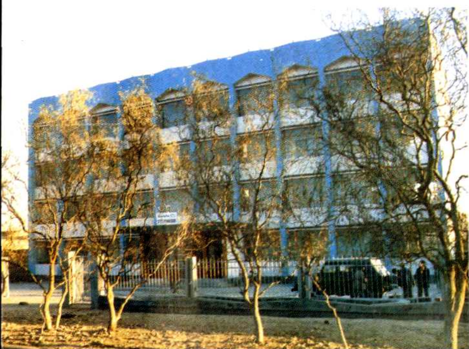
拜城公路段 办公楼
