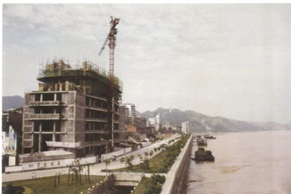
宜宾市滨江路一期工程。
