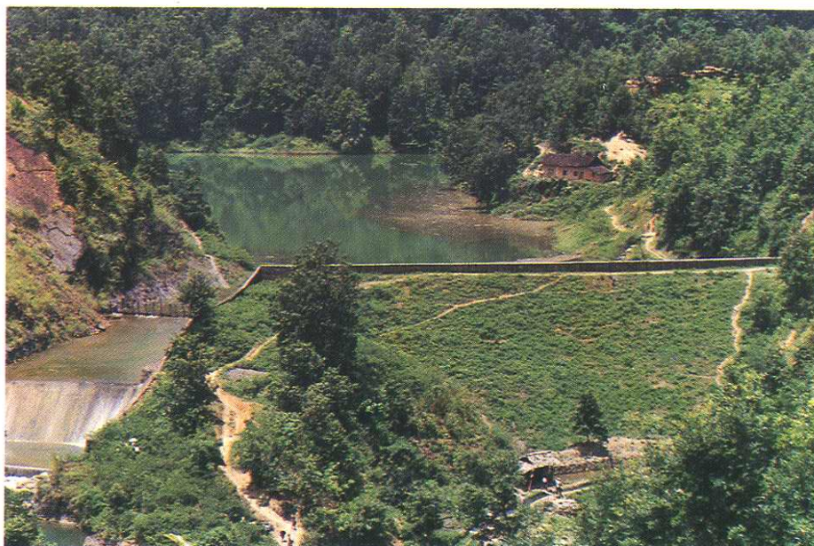
八念水库坝首及溢洪道
