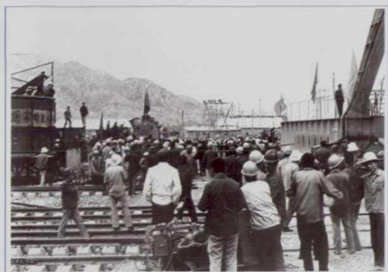
首批设备运抵工地
