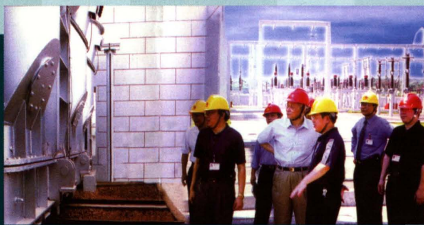
2002年6月14日，湖南省电力公司党组书记、总经理周绍文来响水坝变电站调研。
