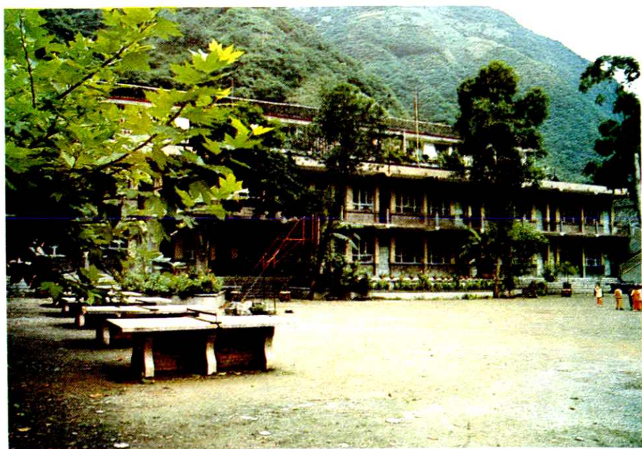
北川县曲山镇小学教学楼之一。
