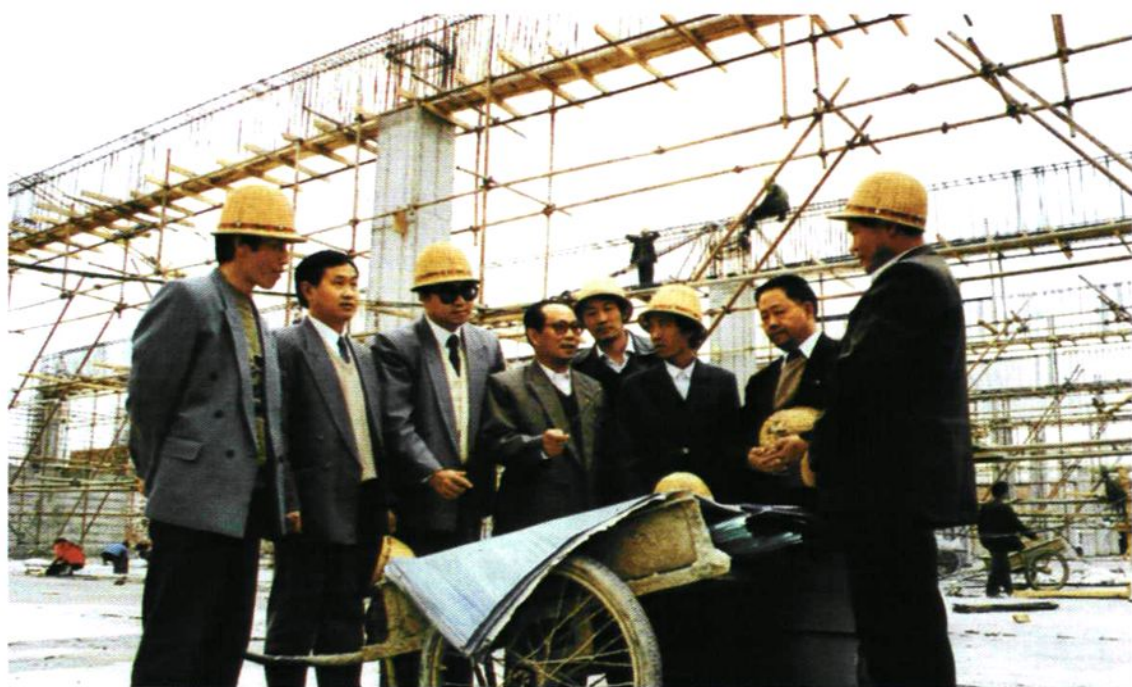
设计人员在施工现场
