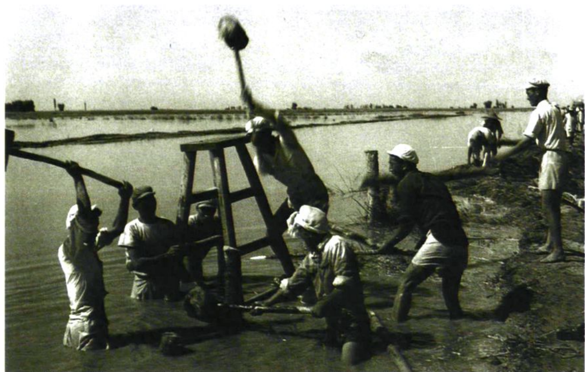
50年代兵团的水利工程建设现场
