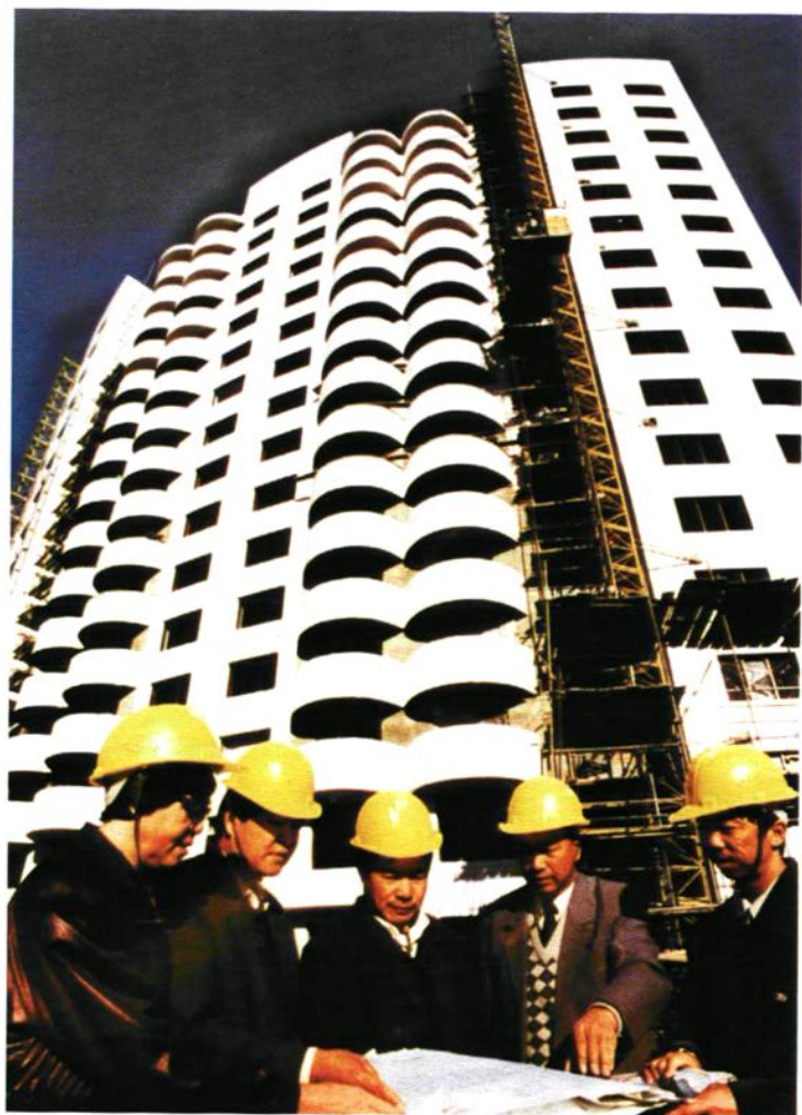
进入21世纪的建筑施工现场
