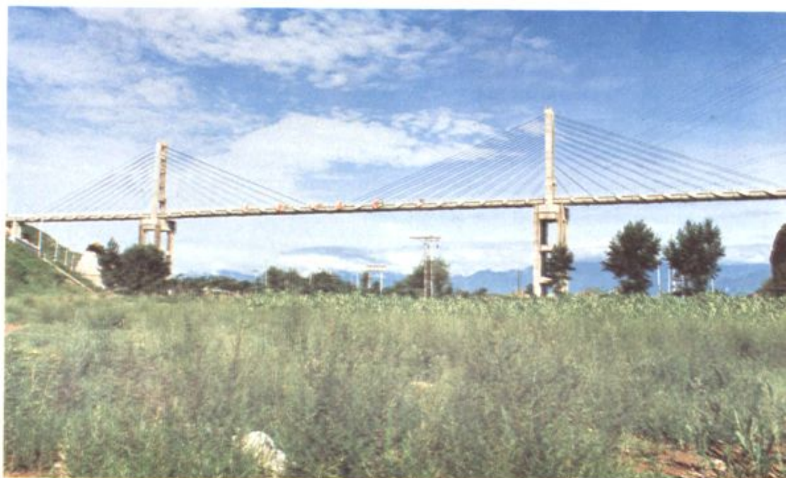
南干渠上的大跨度军都山斜拉渡槽
