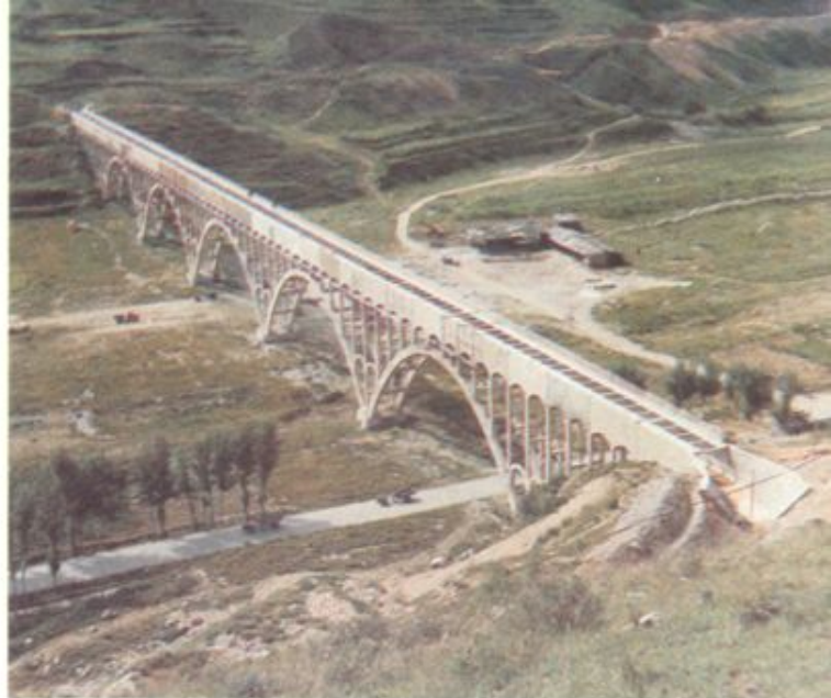
南干渠上的河湾渡槽
