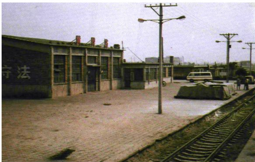
沧黄地方铁路南排河大桥
