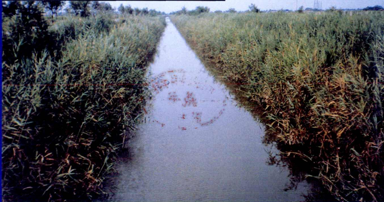
胡张庄村主要排水干渠十三米大沟全长1400米，宽13米，深3.5米，开挖于1978年(人工开挖)
