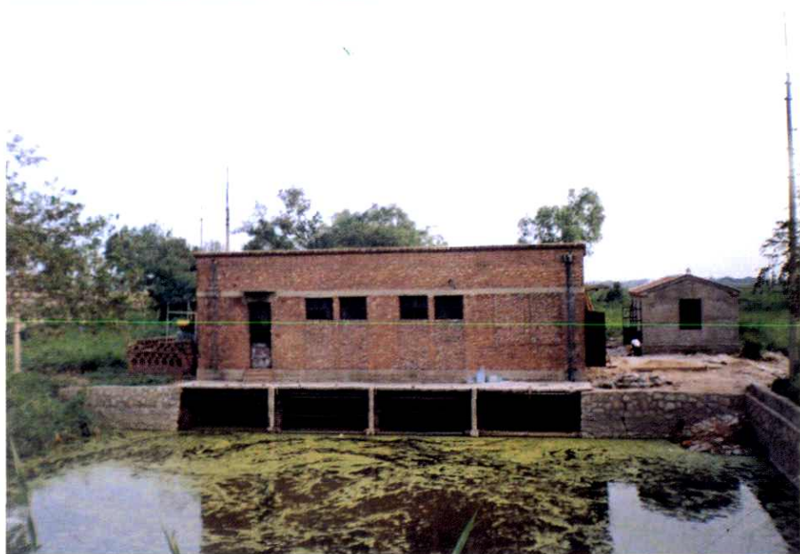
胡张庄村水利设施——村东杨水站 900 水泵两台(104 干校建于1968年) ▶
