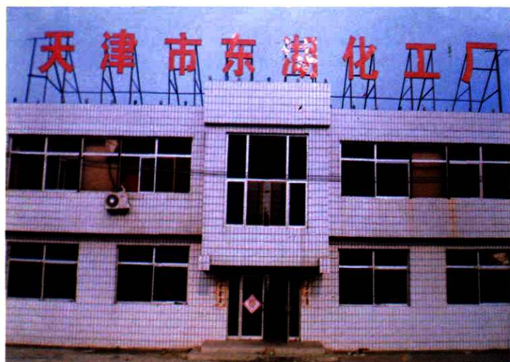
▲ 东湖化工厂办公楼
