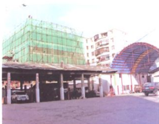
原兰坪县客运公司修理厂
