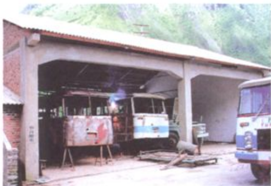
六库总站大修车间一角
