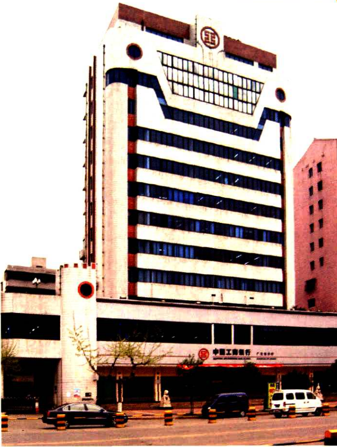
中国工商银行广元市分行办公大楼
