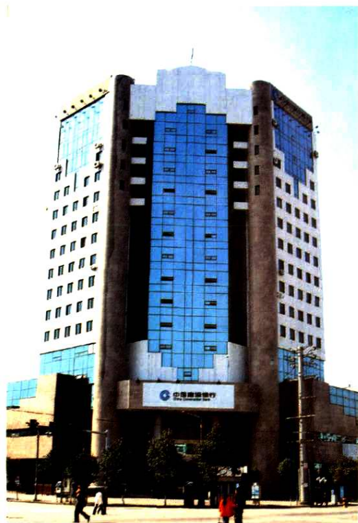
中国建设银行广元市分行办公大楼
