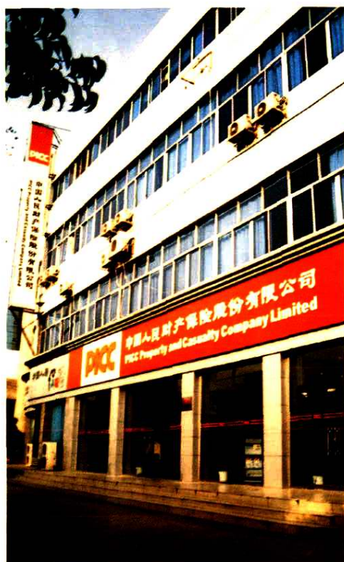
中国人民财产保险股份有限公司 广元市分公司办公大楼
