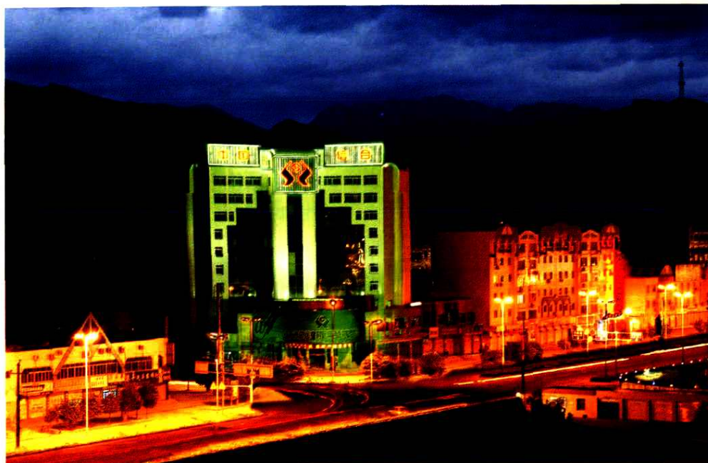
市农村信用社行业管理办公室、市中区农村信用联社办公大楼
