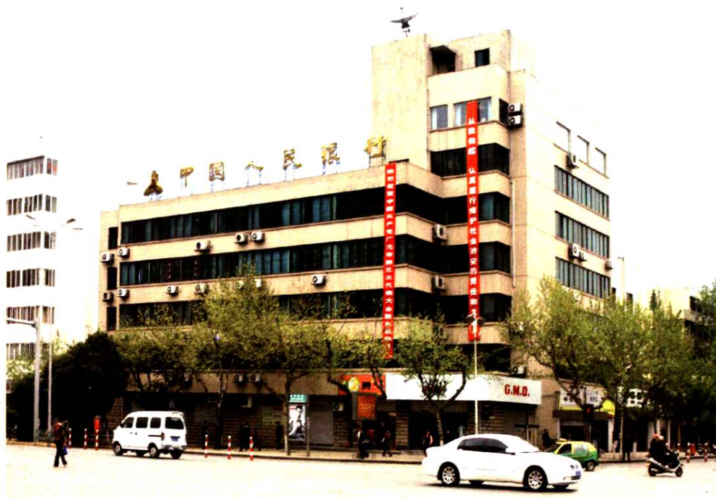
中国人民银行广元市中心支行办公大楼
