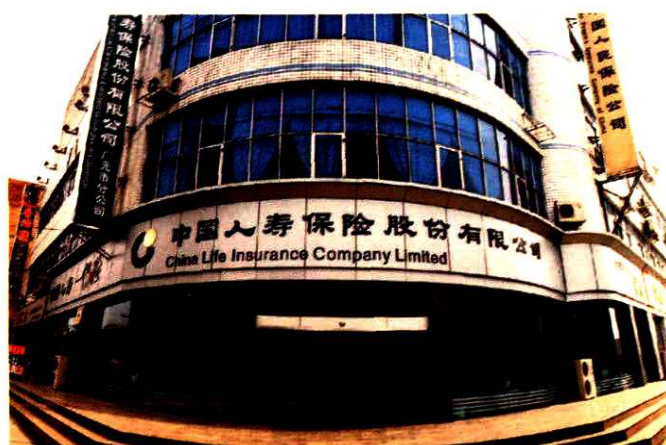
中国人寿保险股份有限公司 广元市分公司办公大楼
