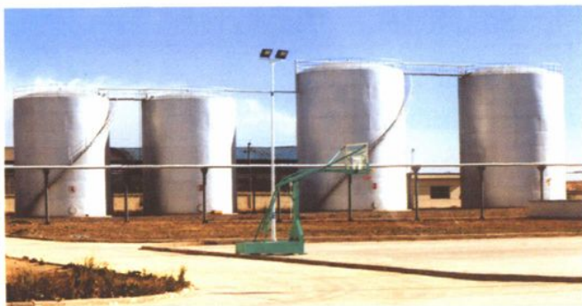
内蒙古新蒙油脂股份有限公司生产设备
