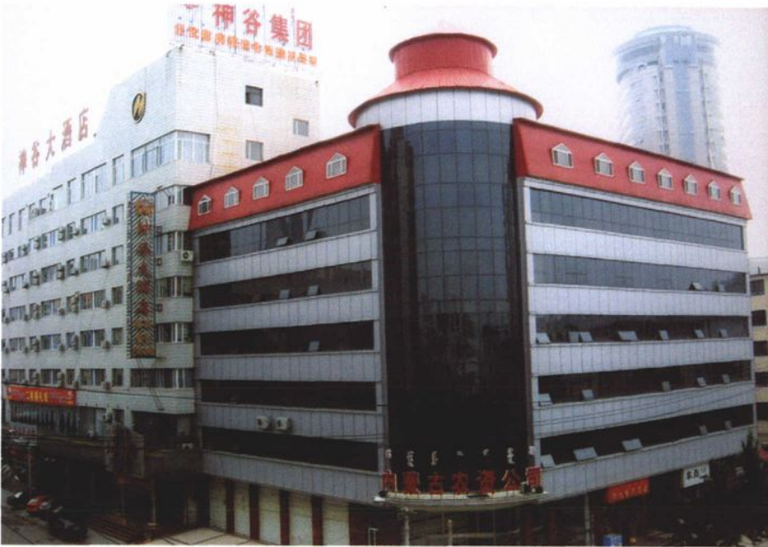
内蒙古农资公司办公大楼
