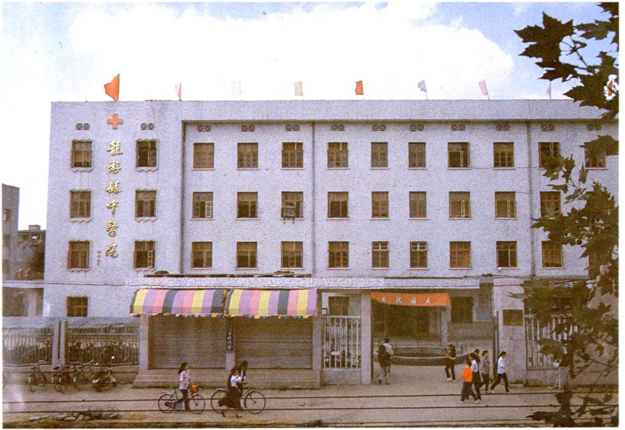
县中医院门诊大楼
