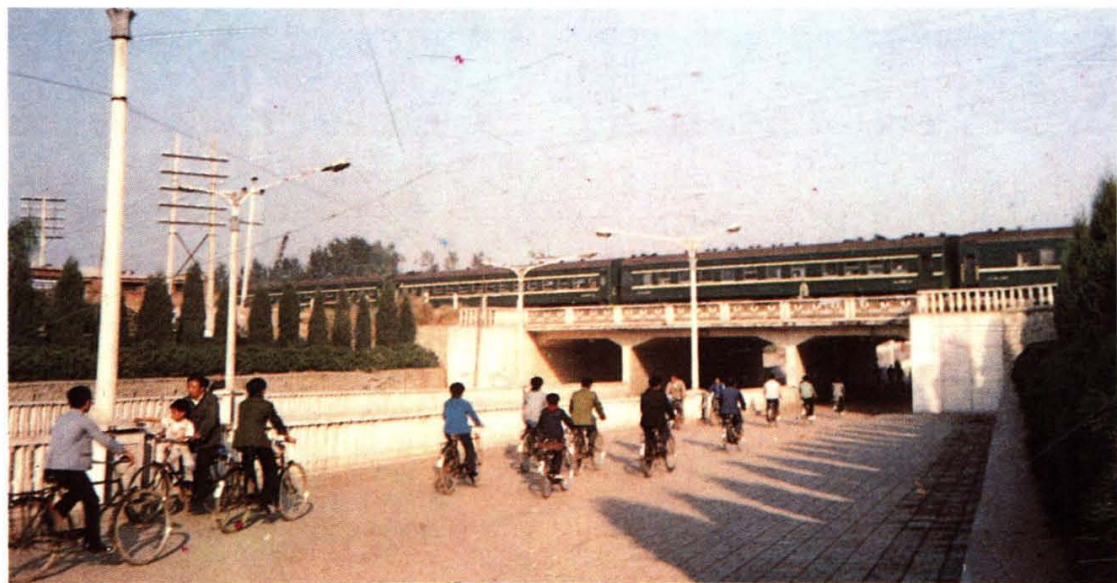
范阳路立交桥
