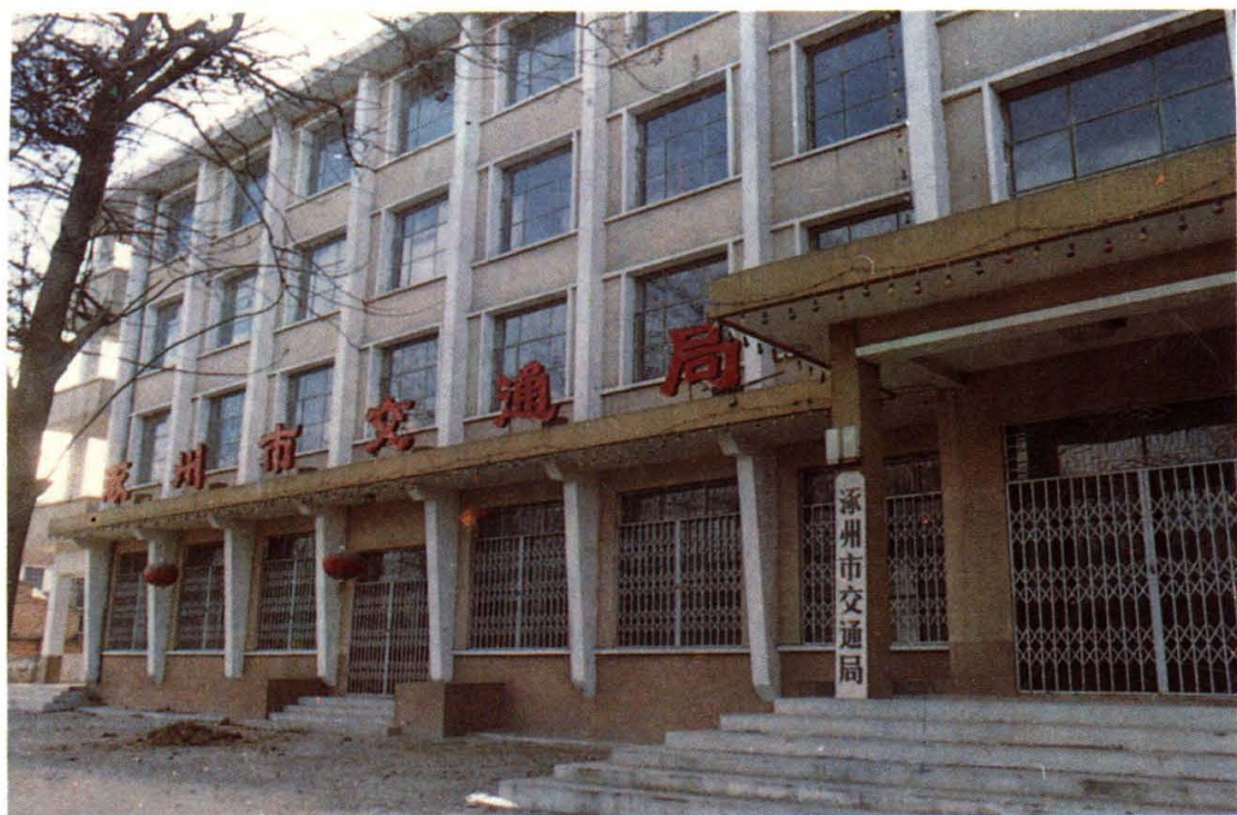
涿州市交通局办公大楼
