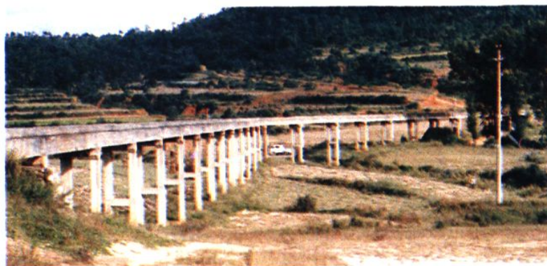
▲ 草铺大箐水库干渠渡槽
