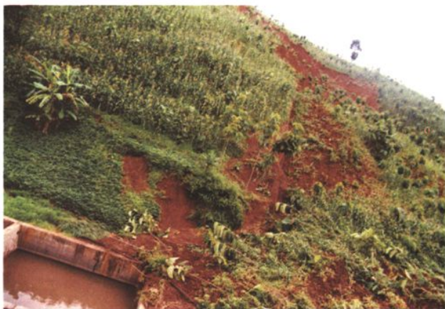
◇山体滑坡灾害
