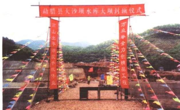
◇ 2004年5月28日，水库大坝封顶仪式
