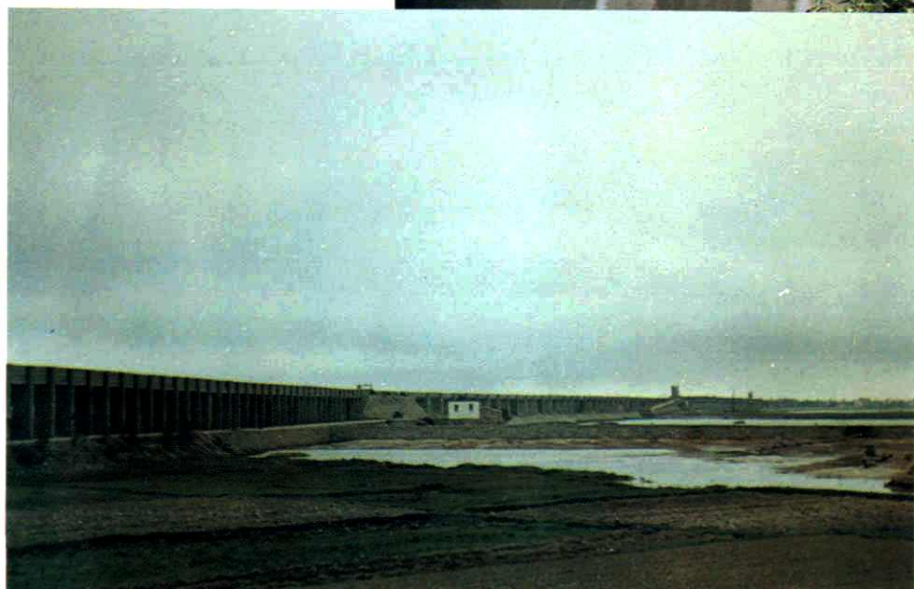
甲东引水渡槽桥
