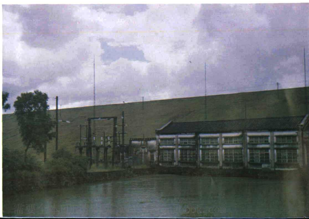
巷口坝后电站
