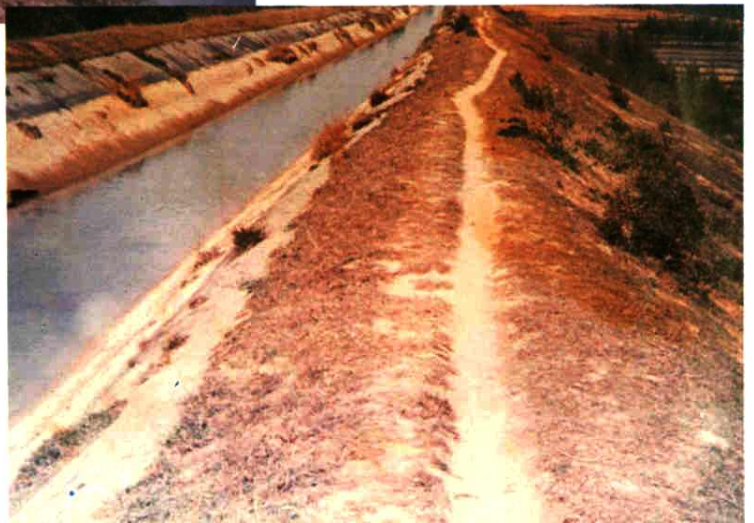
总干渠雨亭段混凝土防渗
