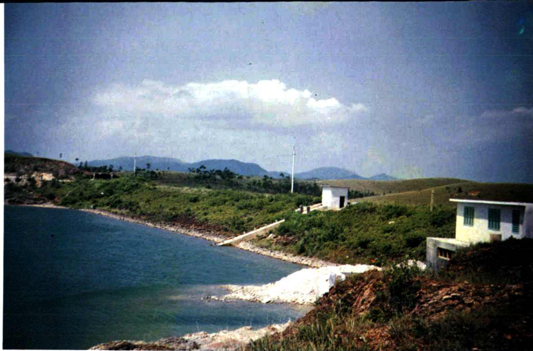
尖山水库主坝及提水站
