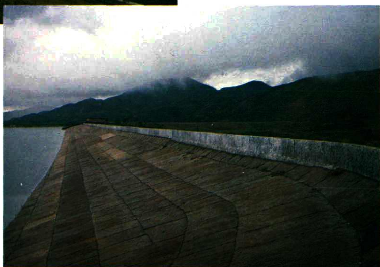
巷口水库北坝混凝土护坡
