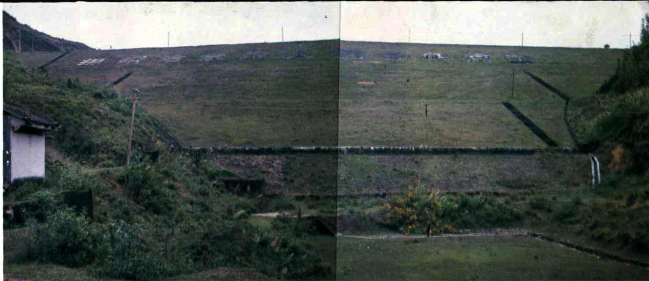
龙潭水库主坝
