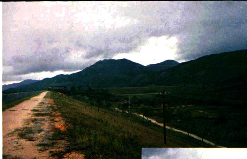
巷口水库北坝及主坝（远处）
