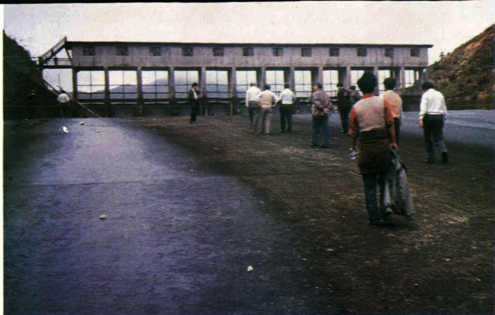
溢洪闸下游面
