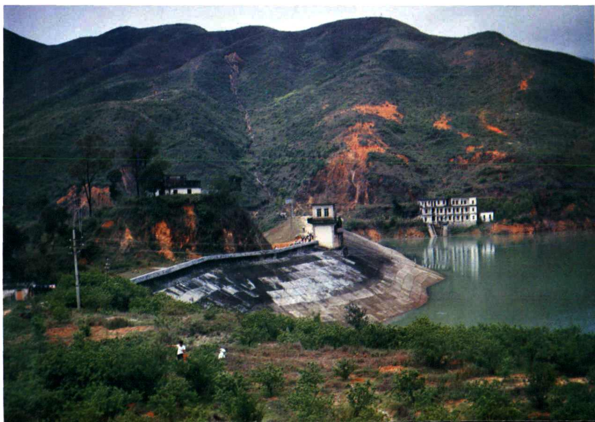
主、副坝内坡及开关室
