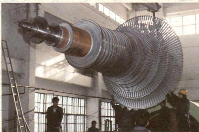
检修汽轮机吊转子现场
