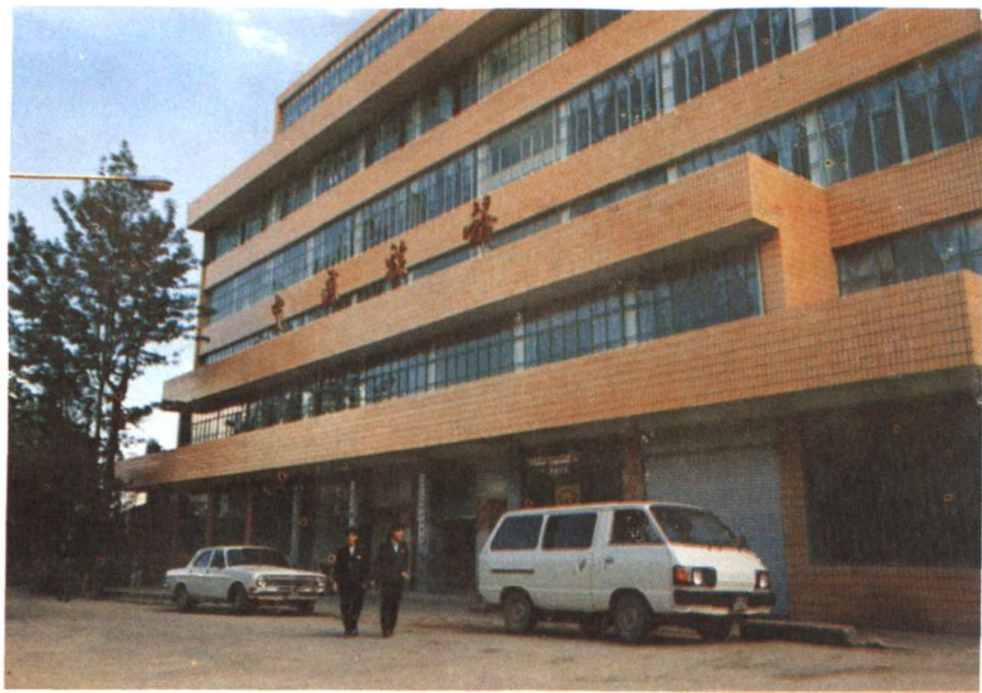
地局新建办公楼
