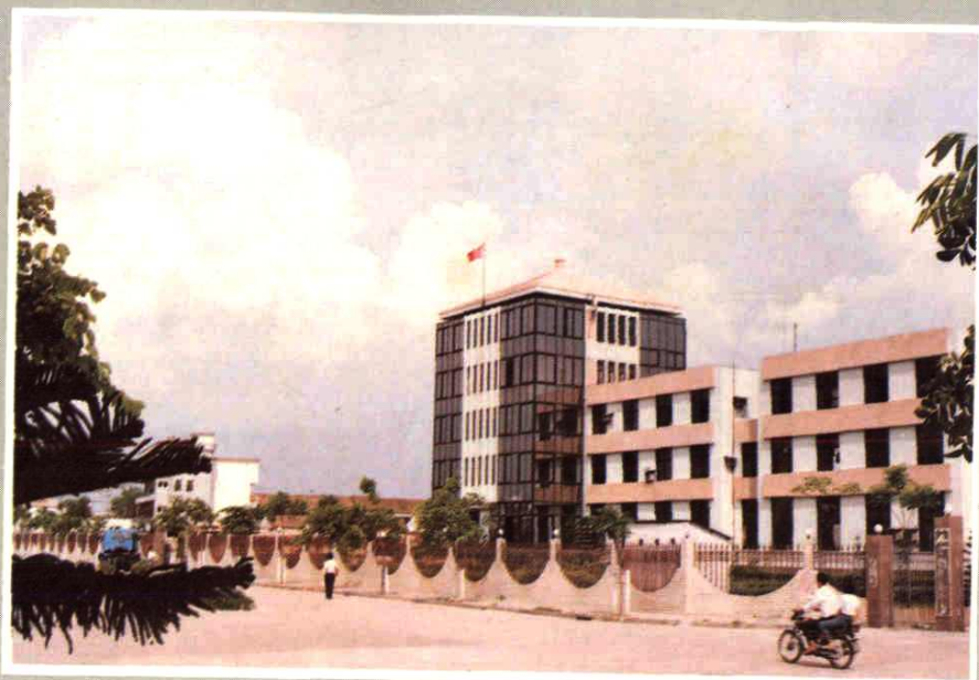
新塘海关办公大楼
