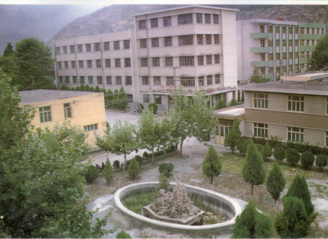
▲茂县人民医院住院部全景
