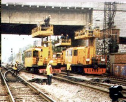
接触网大修换线
