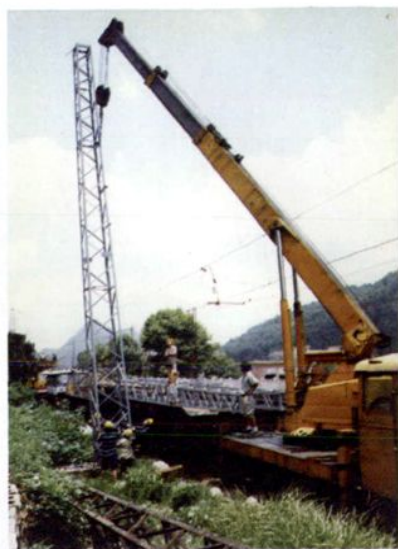
更换接触网钢柱
