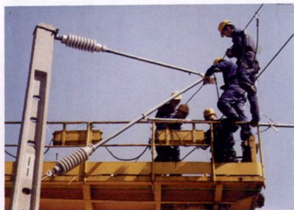
作业车上施工
