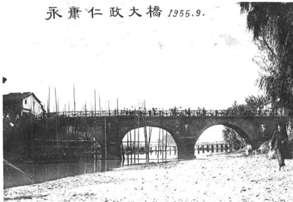
仁政桥在拆建
