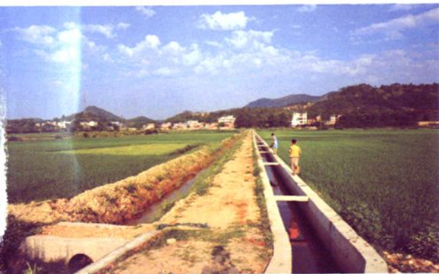
基本农田保护——县国土局在梓山镇河坑村实施土地整理项目
