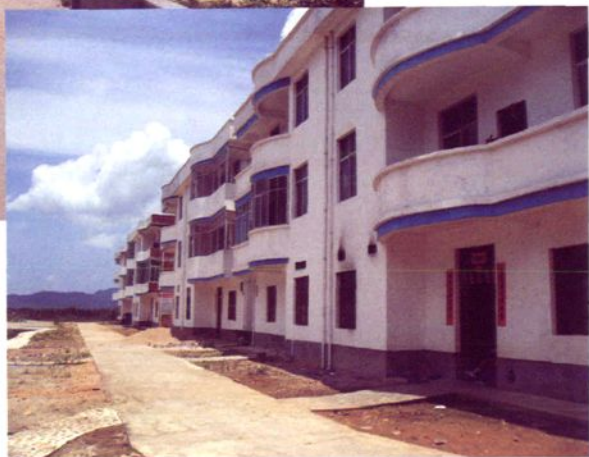
禾丰黄田村拆旧建新示范点
