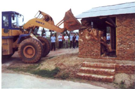
2009年6月12日工业园违法建筑拆除现场
