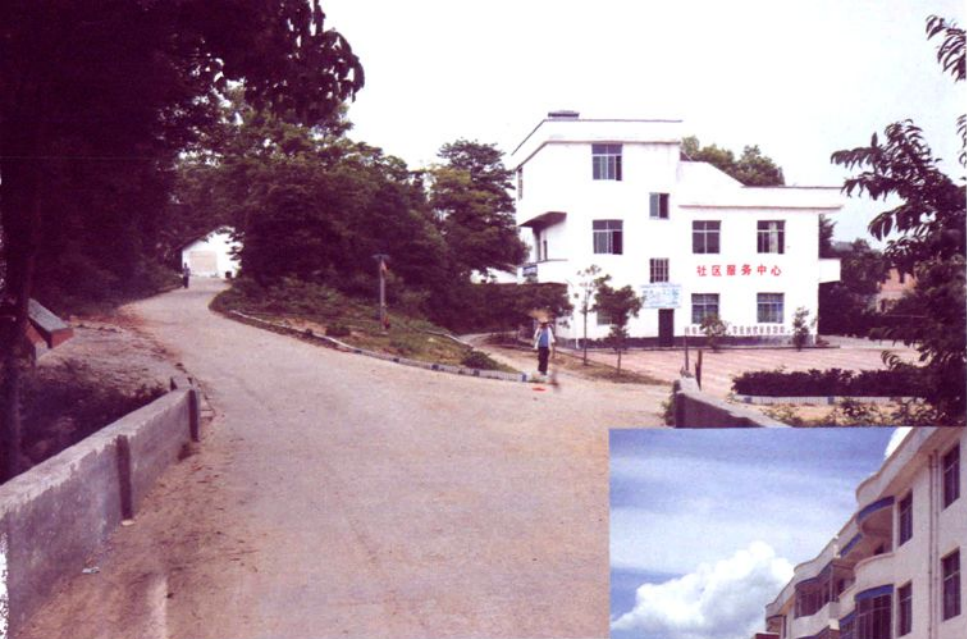
县国土局在新农村建设挂点村——仙下富坑村投资修建的水泥路。
