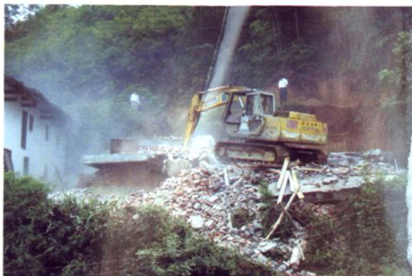
依法强制拆除违法违规建筑现场。
