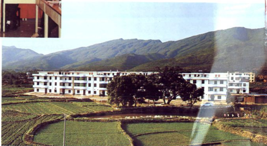
禾丰镇黄田空心村整治后的新貌
