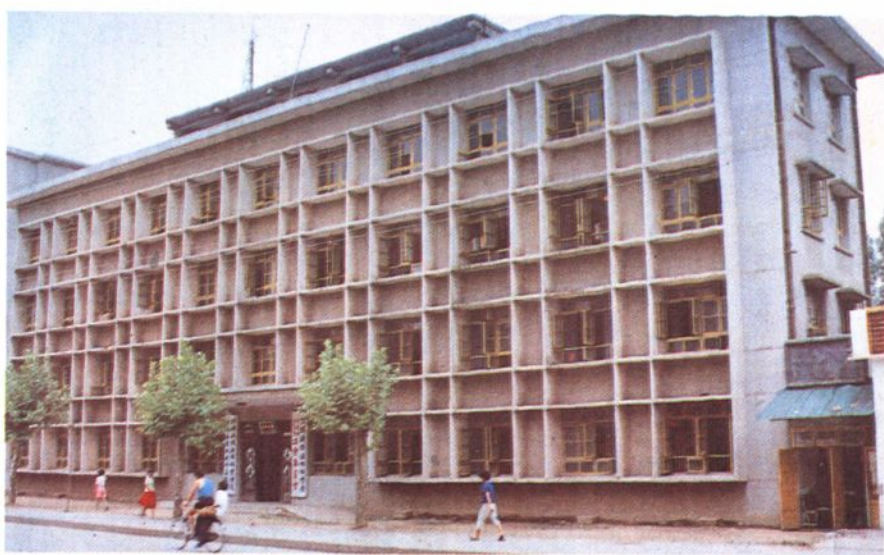
公安县农业机械管理局办公楼
