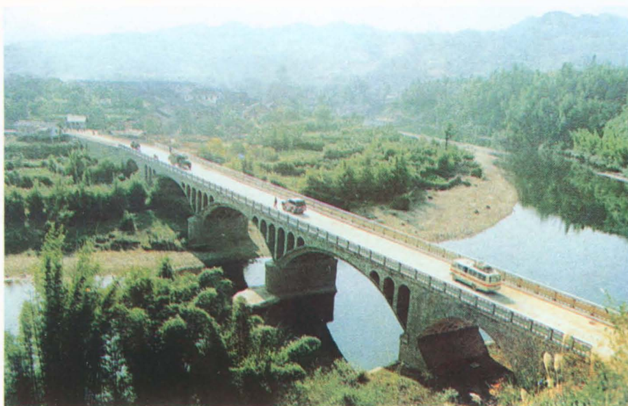
▲ 岗伟村公路桥
