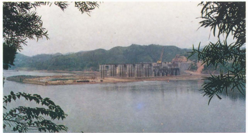
▲ 在建装机 5.4 万千瓦融江浮石水电站
