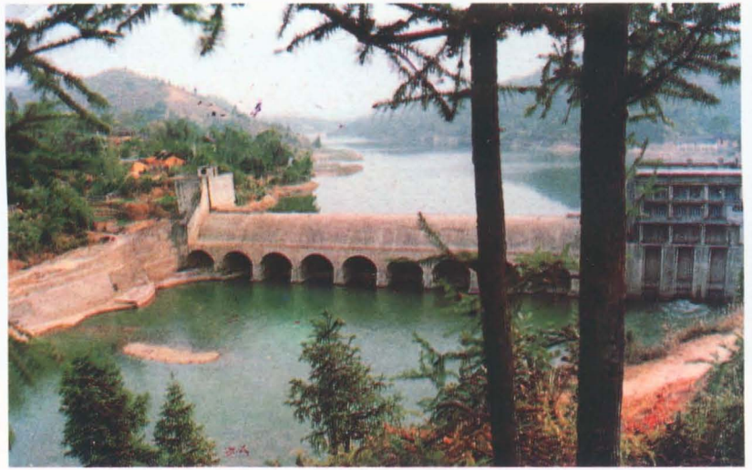
▲ 淑母河水电站
