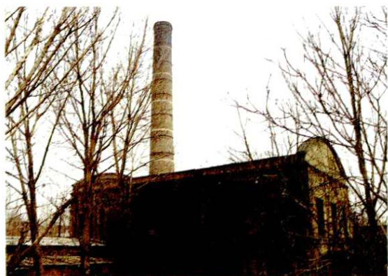
晋华纺织厂源涡发电厂旧址
