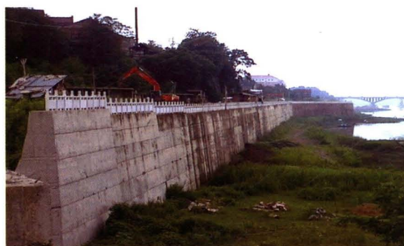
2006年，建成后的安陆城市防洪工程。
