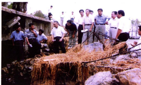
省、市领导及水利部门负责人到民乐闸抢险现场察看险情，指导抢险。
