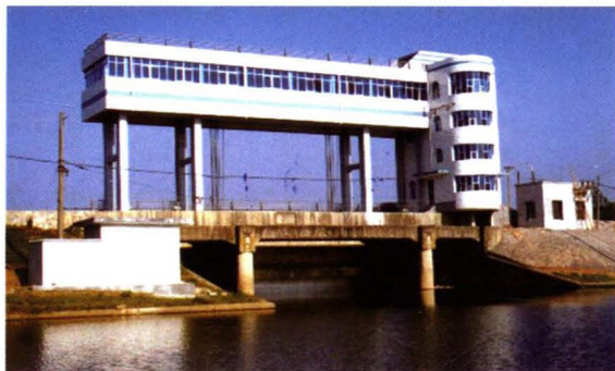
经历1998年险情后，国家安排资金对民乐闸进行除险加固，民乐闸面貌一新。
