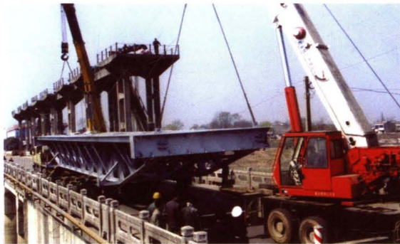
1998年大洪水后，对新沟闸全面进行除险整险，大型机械正在吊装闸门。
