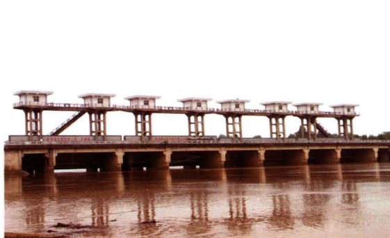
2003年，改造完工后的新沟闸正在开闸泄洪。
