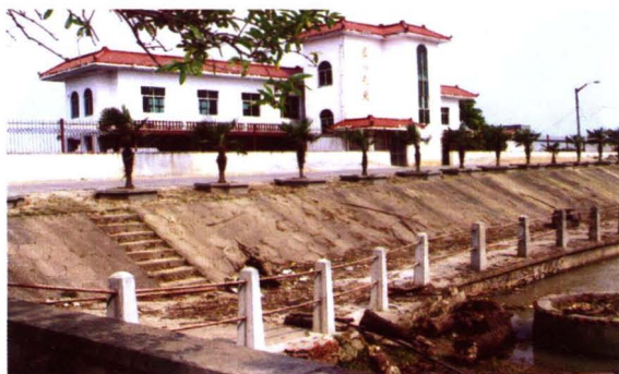
1960年5月建成的东山头北闸（老闸）经过了整修加固。
