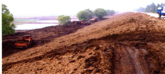
2005年春，府河堤防（八一大桥下段）加培施工。
