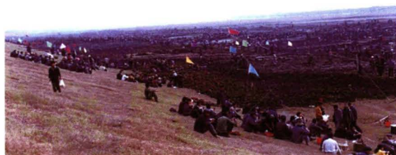
1994年、1995年连续两年冬季对汉北河实施扩南河、挖北河、平滩灭螺的综合治理工程。图为有40万人参战的施工场面一瞥。
