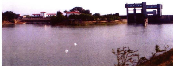
新建、改建加固后的东山头南（右）北（左）闸全景（上游侧）。
