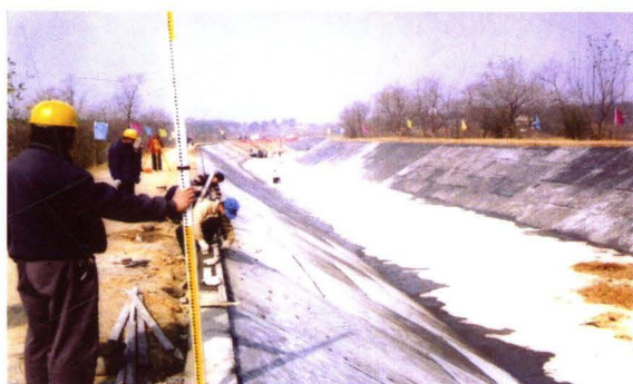
徐家河灌区干渠续建配套与节水改造施工（2004年）。
