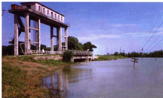
出险前，长时间受高水位浸泡下的民乐闸（1998年8月）。
