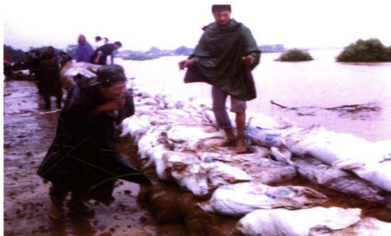
水涨堤高。1996年7月17日，潯河大洪水，约2公里长的堤开始漫堤，孝感城区防洪堤面临严重威胁，防守人员抢筑子堤挡水，18日5时洪峰过境，潯河堤全线安然无恙。
