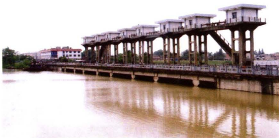
2003年改造完成后的新沟闸正在开闸泄洪。
