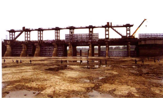
新沟闸除险整险工程紧张施工中。
