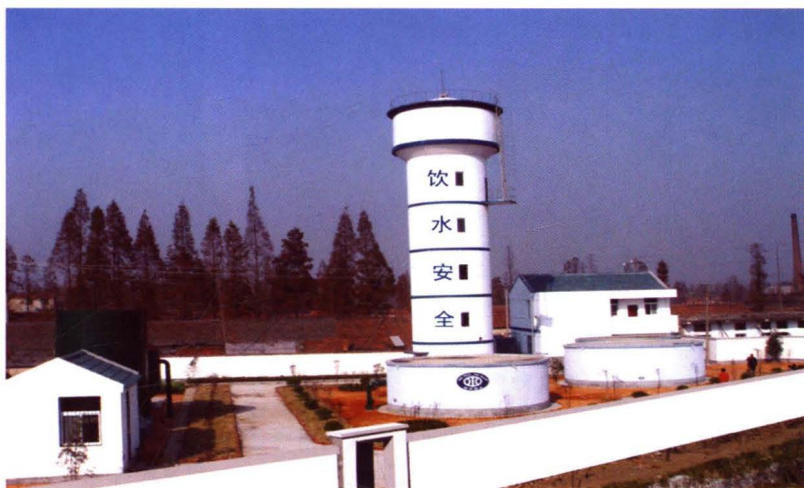
2007年建成投入使用的孝南区朱湖四汊联村供水工程。
