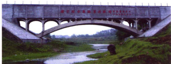
整修加固后的徐家河灌区干渠陆家湾渡槽（2003年）。
