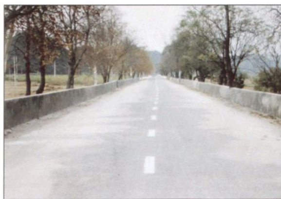
▲ 省道柯龙线安保工程
