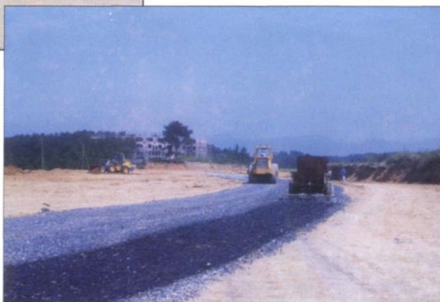
省道武修线二级油路施工工地 ▶
