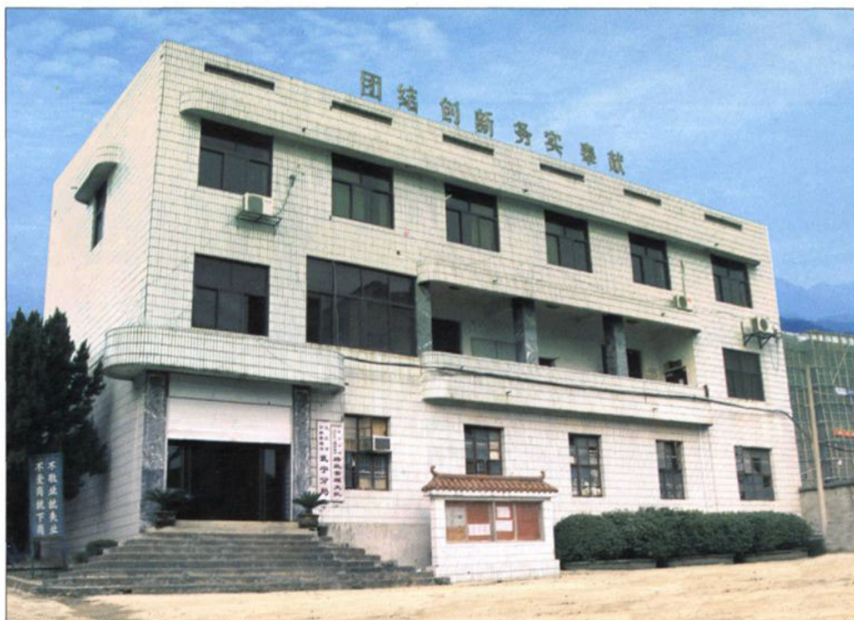
▲ 武宁公路分局办公大楼
