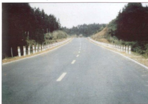
▲ 省道武（宁）修（水）二级公路
