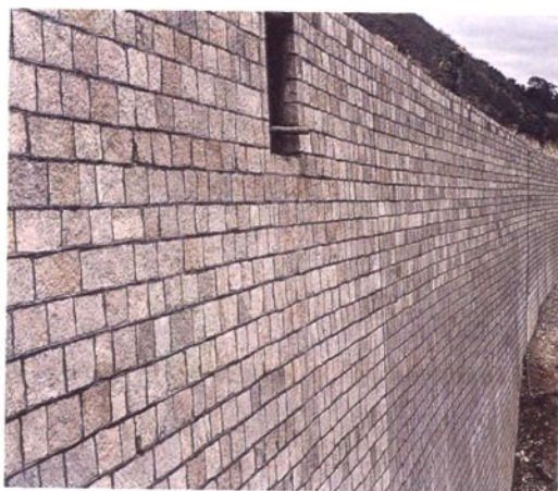
机筑处在外福铁路施工的最长下挡工程
