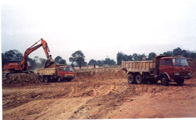
正在施工的南宁铁路枢纽工程
