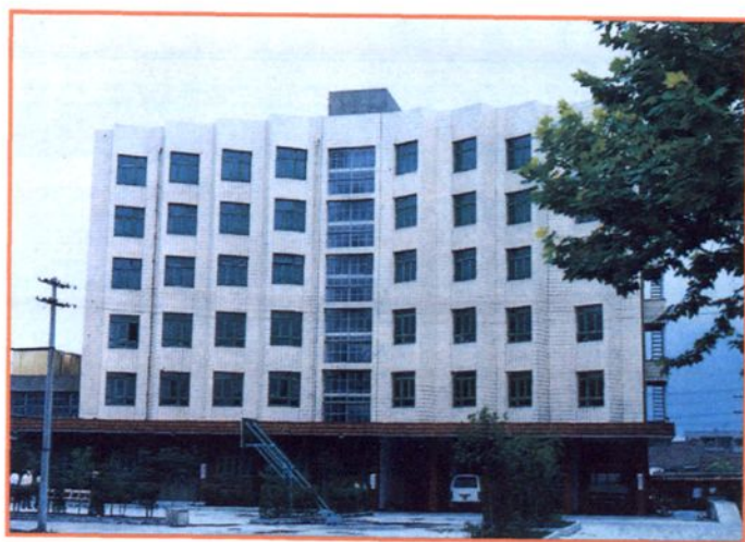
处机关综合大楼
