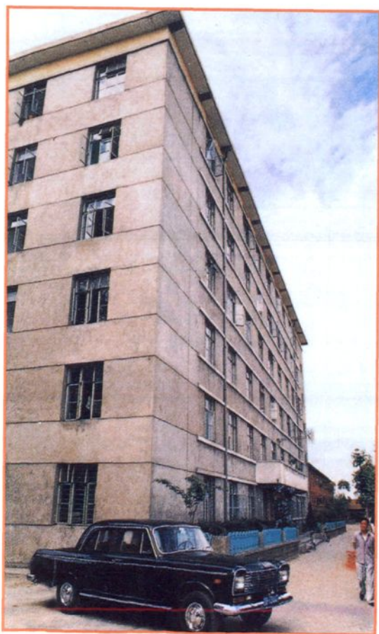
处机关办公大楼
