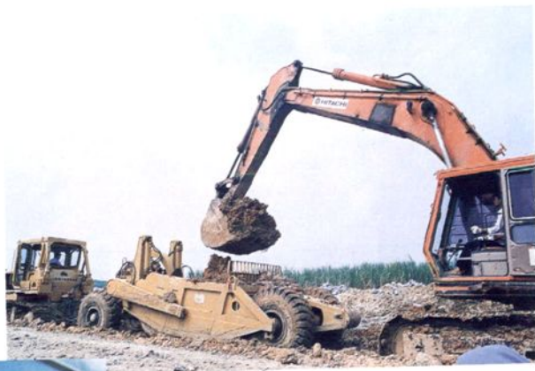
成昆线机械化施工
