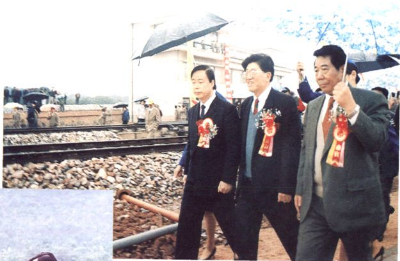
1995年11月20日，铁道部部长韩杼滨、副部长孙永福视察株洲铁路枢纽机筑处施工工地。
