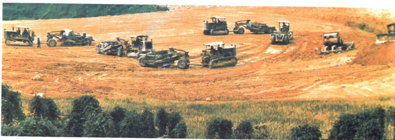
外福铁路机筑处采用推铲机械进行土方施工
