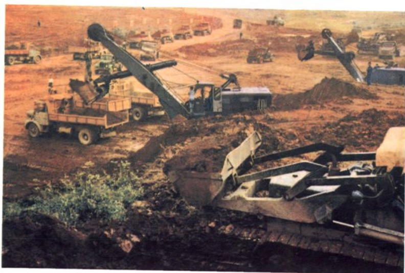
湘黔铁路凯里车站施工
