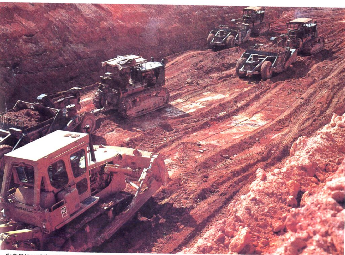
衡广复线机械施工场景
