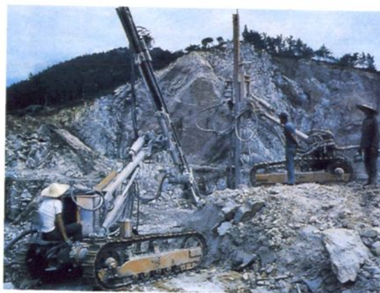
潜孔钻机控爆钻孔作业
