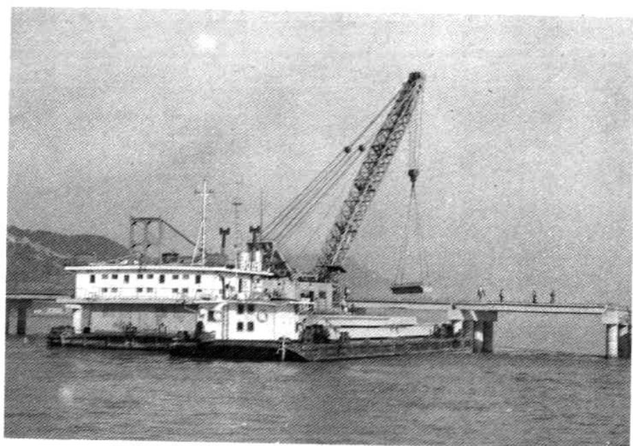
乍浦港施工船吊装栈桥面板 江强摄
