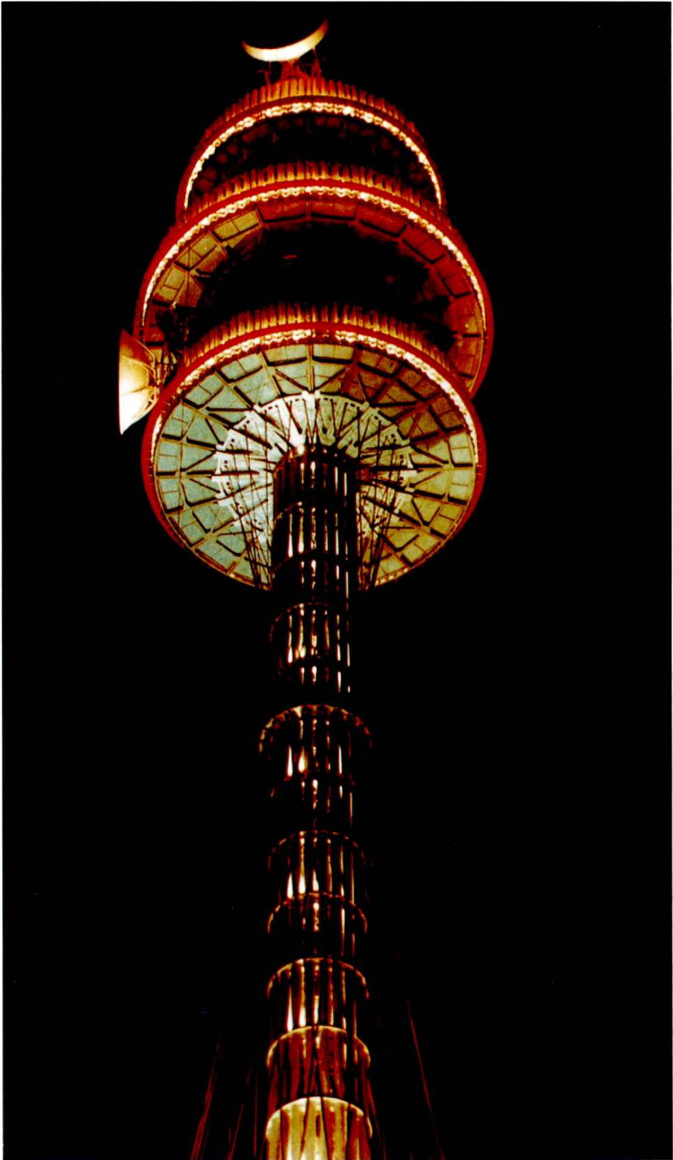
电网调度微波塔
