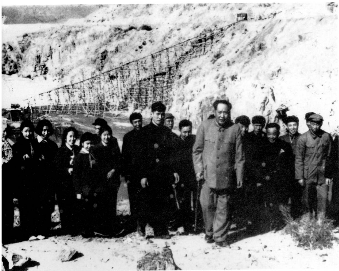
1954年4月，毛泽东主席视察官厅水库及水电站工地
