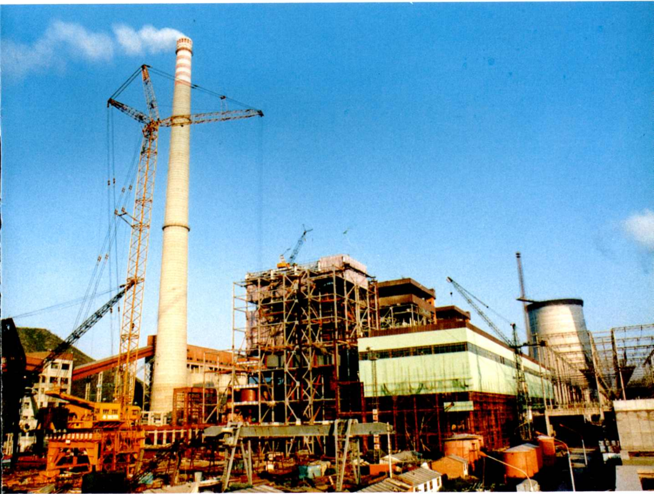
▼建设中的石景山热电厂
