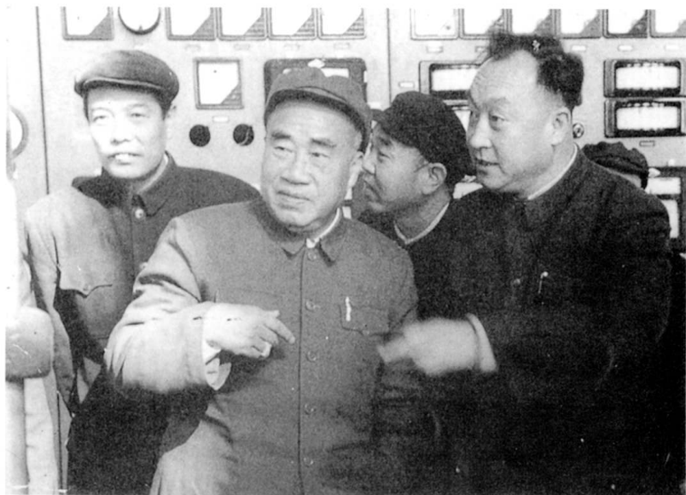
1959年11月2日,朱德委员长视察北京热电厂
