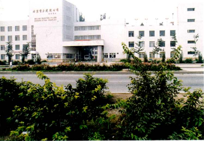
▲北京电力建设公司
