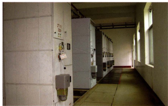
楚江变电站工作室
