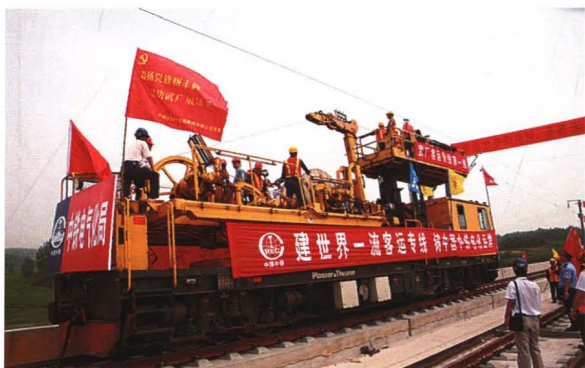
武广高铁牵引供电系统工程施工
