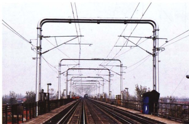
京九电化九江长江大桥接触网工程
