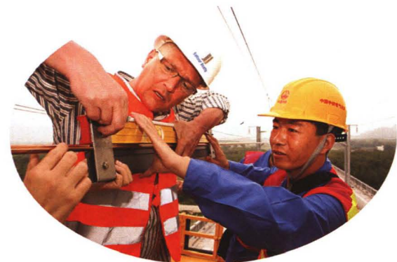
中外技术专家在武广客专进行接触网导线平直度检测
