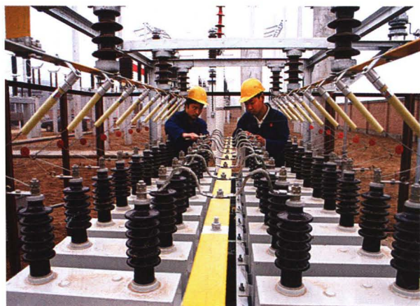
京沪变电施工
