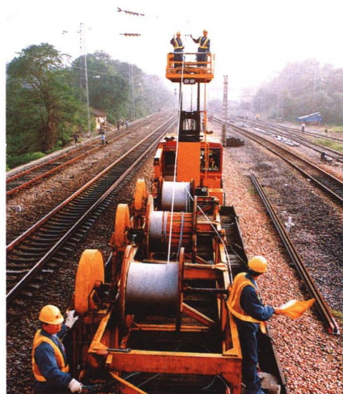
京广线武广段电气化接触网施工架设承力索
