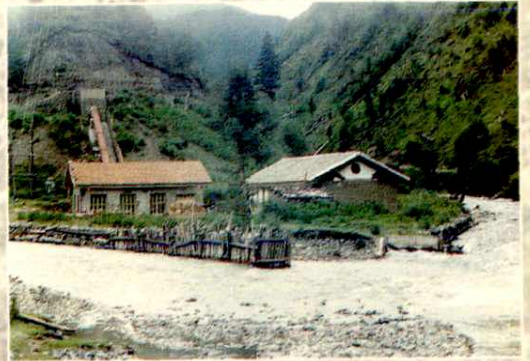
偏僻地区六巴乡两河口电站装机200千瓦
